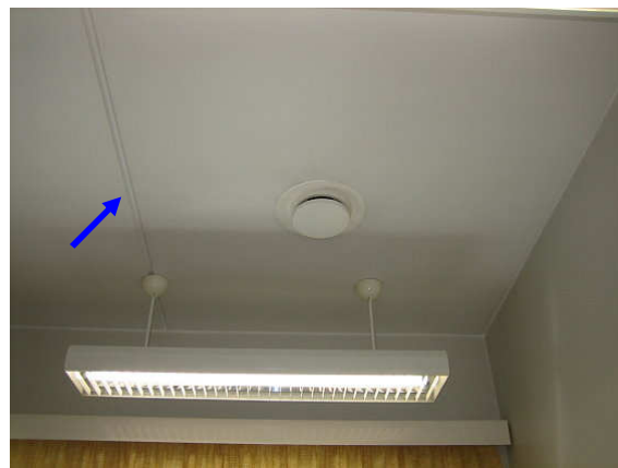
Kuva 2 Ensimmäinen ontelolaatta päädyistä lukien. Saumakohta päätyseinästä 1360 mm etäisyydellä.
