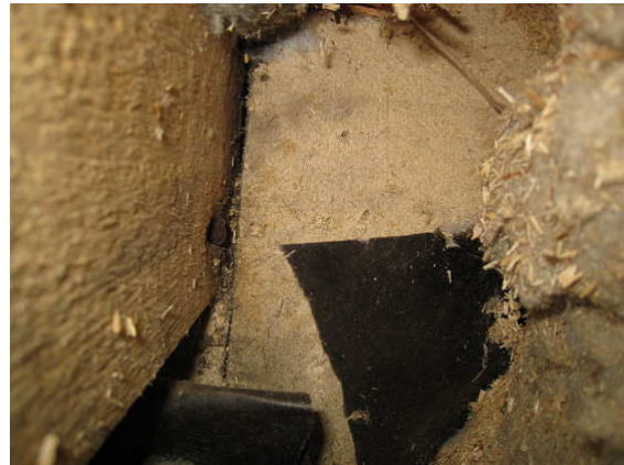
Kuva 8 Materiaalinäyte sahanpurusta, lahopuusta ja riveistä (kts. testausseoste). Ulkoseinän puolella puukuitulevyä.
