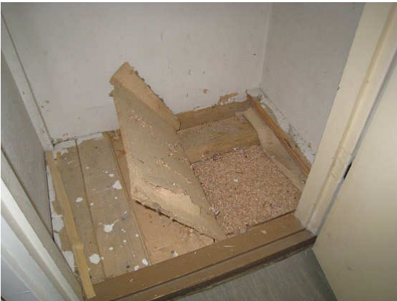
Kuva 7 Komeron kohdalle lattiaan tehtiin rakenneavaus.
