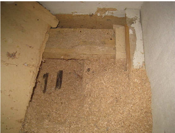
Kuva 19 Lämpöputket ovat ulkoseinän vierustalla eristetilassa.
