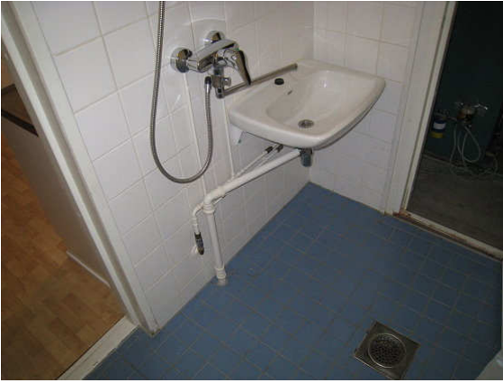
Kuva 17 1.asunnon laatoitettu pesuhuone.
