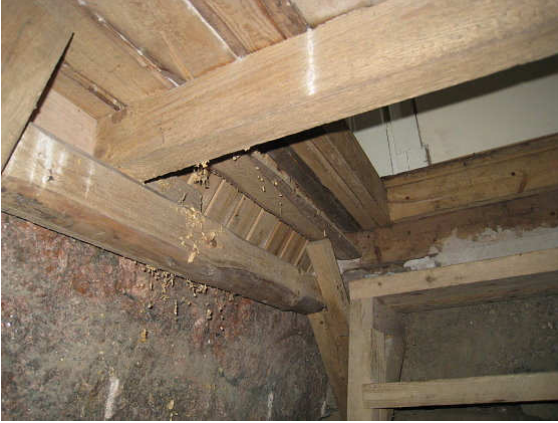
Kuva 5 Asunnon 1 kohdalla kellaritila.
