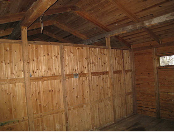
Kuva 11 Varastorakennus sisältäpäin kuvattuna.
