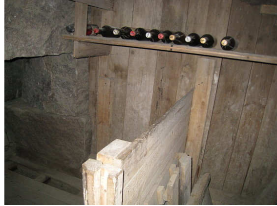
Kuva 6 Perunalaarien puurakenteet ovat kosteus- ja mikrobivaurioituneet betonin vasten olevissa pinnoissa.
