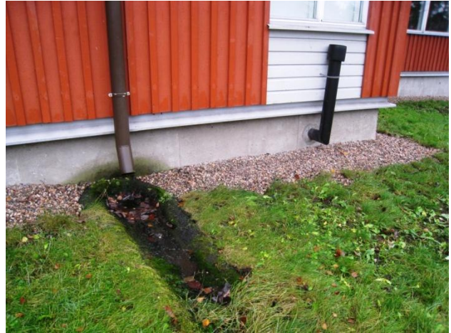
Kuva 9 Perusrakenteelle aiheutuu kosteusrasitusta.
