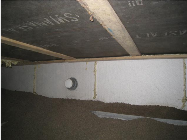
Kuva 8 Tuuletusputkissa venttiilit.
