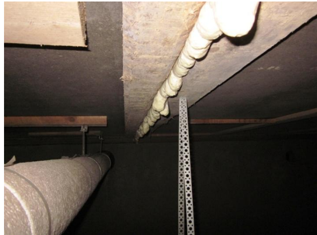
Kuva 2 Saumoja on tiivistetty polyuretaanivaahdolla.
