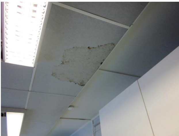
Kuva 19 Vesivuotojälki leikki-/lepotilassa 41.
