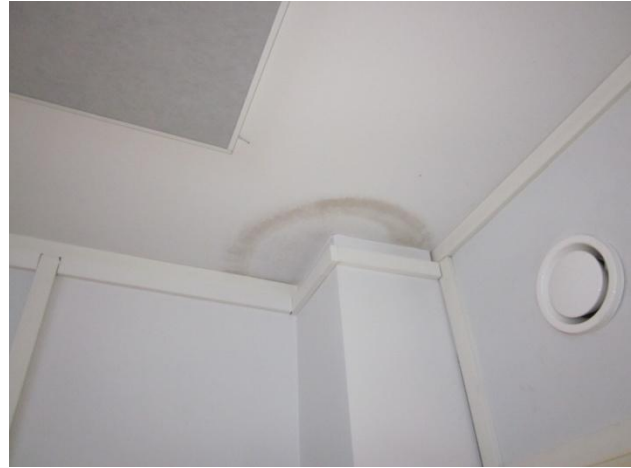
Kuva 18 Vesivuotojälki ryhmähuoneessa 48.
