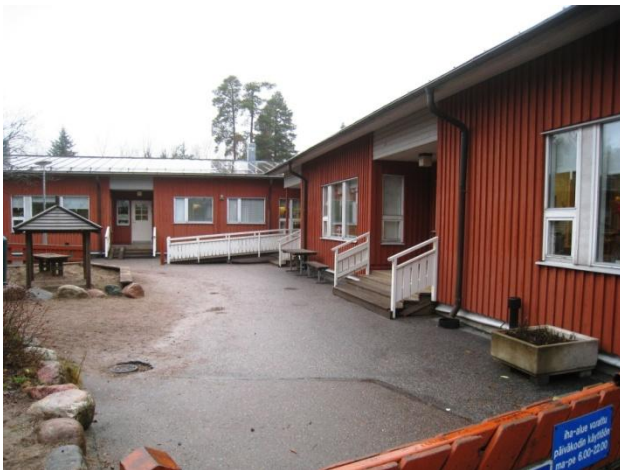
Kuva 3 Sokkeli on matala sisäpihan puoleisilla sivuilla.
