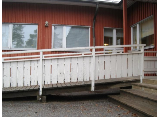
Kuva 8 Puurakenteet alkavat olla huoltomaalauksen tarpeessa.
