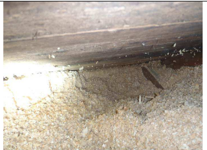
10. Yläpohjan vino-osaa eristeiden siirtämisen jälkeen
