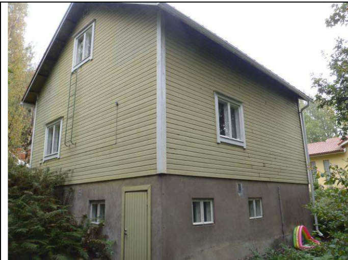
2. Rakennuksen takasivua ja -päätyä
