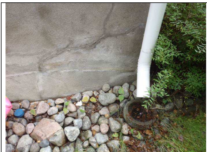
1. Kattovedet on johdettu rakennuksen nurkilla kaivoihin
