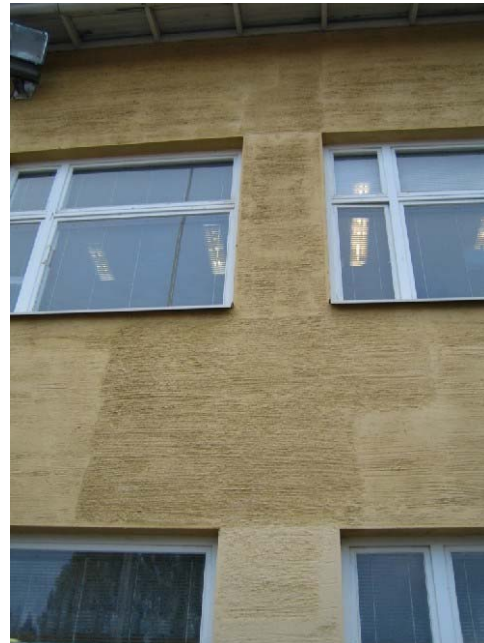
Kuva 9. Laastipaikkaukset erottuvat selvästi erilaisen pintastruktuurin vuoksi (V).
