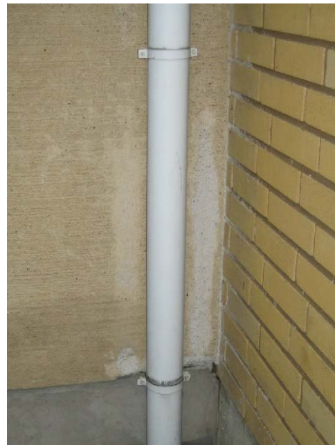
Kuva 17. Pintarapautumista rappauksessa, yhdyskäytävän kohta, länsi julkisivu (V).
