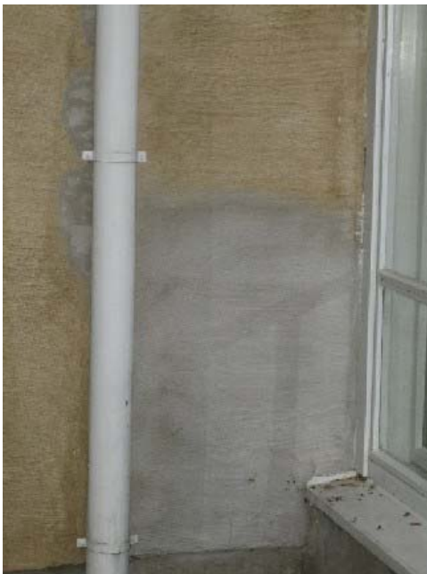
Kuva 19. Korjattu rappaus on kopo, samoin vanha rappaus korjauksen ympäriltä (U).
