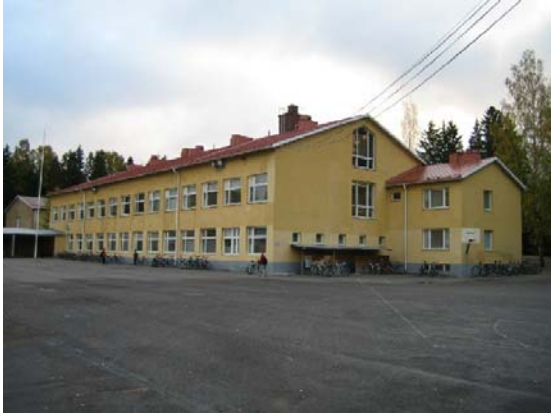
Kuva 1. Vanha rakennus sisäpihalle (V). Uudempi rakennus pilkistää taka-alalla vasemmalla.
