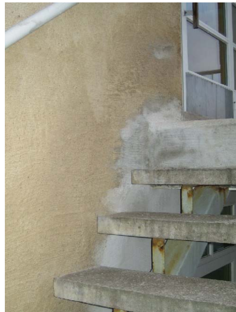
21. Parvekelaatan liittymä uudemman osan seinäpintaan on korjattu. Paikattu alue on jo kopo (U).
