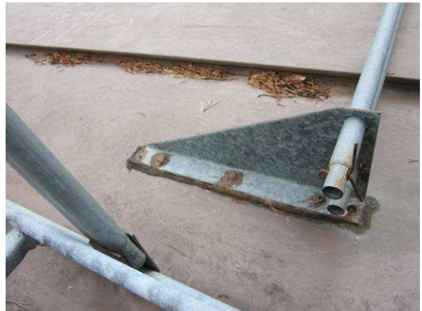
Lumiesteiden kiinnikekohtia on paikattu kittamalla
