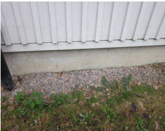
Betonisokkelit ovat tyydyttävässä kunnossa
