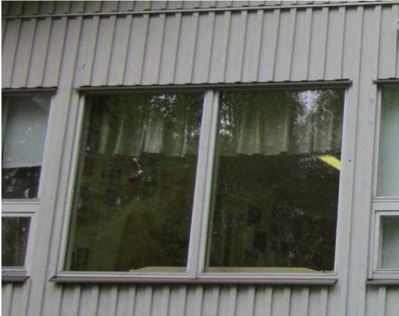
Rakennuksen ikkunat ovat alkuperäisiä puuikkunoita. Ikkunat ovat pääosin lämpölasielementtejä.
