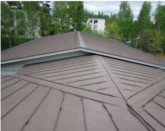
Yleiskuvaa vesikatolta, katemateriaali on konesaumattu peltikate
