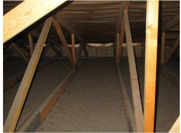
Kuvaa alaräystäältä, tuuletus alaräystäiltä OK
