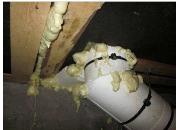
Alapohjan läpiviennit on tiivistetty uretaanilla
