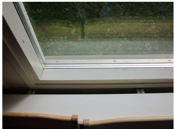
Rakennuksen ikkunat ovat alkuperäisiä puuikkunoita Ikkunat ovat pääosin lämpölasielementtejä
