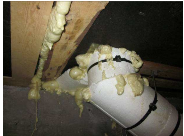
Alapohjan läpiviennit on tiivistetty uretaanilla
