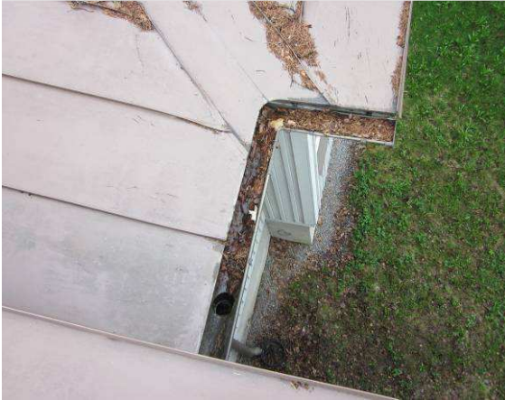
Räystäskourut kannattaa puhdistaa säännöllisesti
