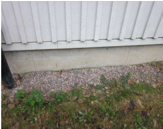
Betonisokkelit ovat tyydyttävässä kunnossa
