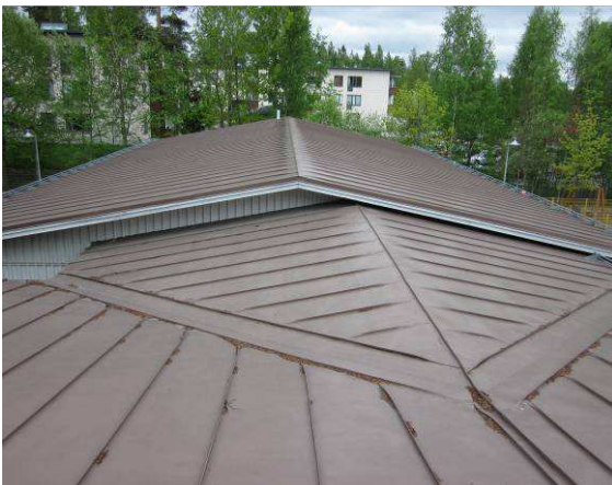
Yleiskuvaa vesikatolta, katemateriaali on konesaumattu peltikate
