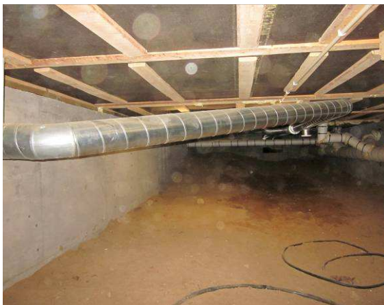
Alapohjatilan perusmaa hienorakeista hiekkaa, hiekan pinta oli keskialueella kosteaa
