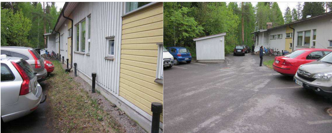
Sokkelin vierustalla asianmukainen sora- tus, alapohjan tuuletusputkia on arviolta riittävästi
