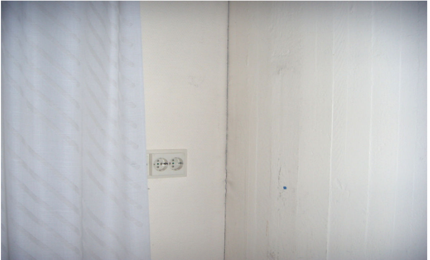
KUVA 13. Yleiskuva päiväkodin rakenteista.
