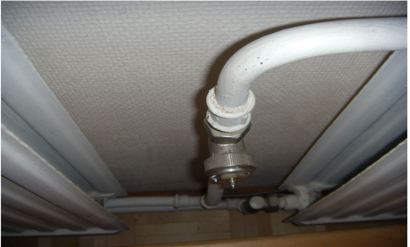
KUVA 17. Yleiskuva liikuntasalin patteriventtiilistä.
