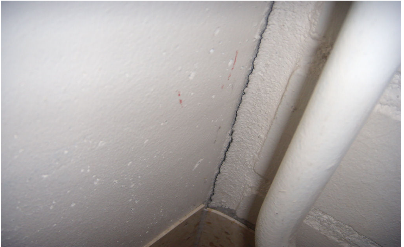
KUVA 15. Yleiskuva päiväkodin rakenteista.
