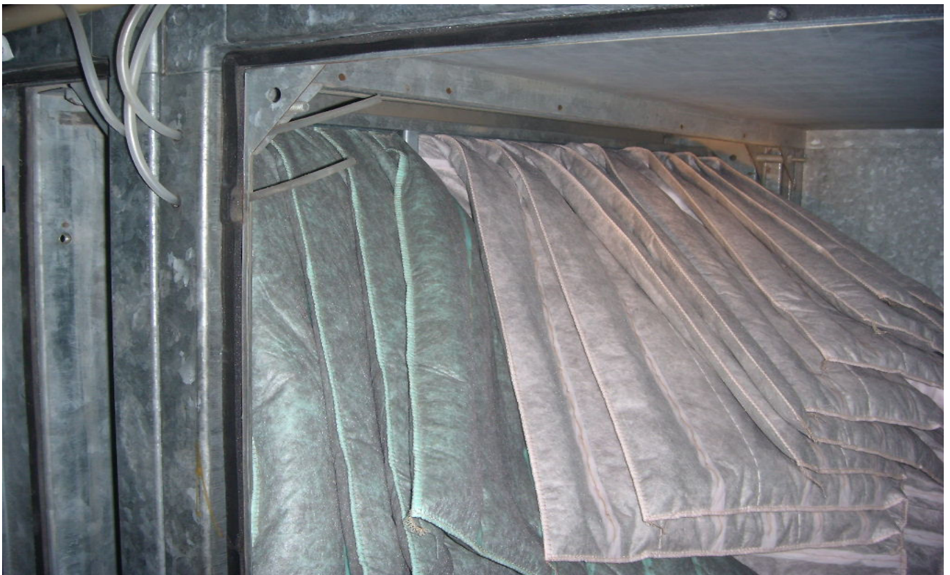
KUVA 2. Yleiskuva tuloilmasuodattimista.
