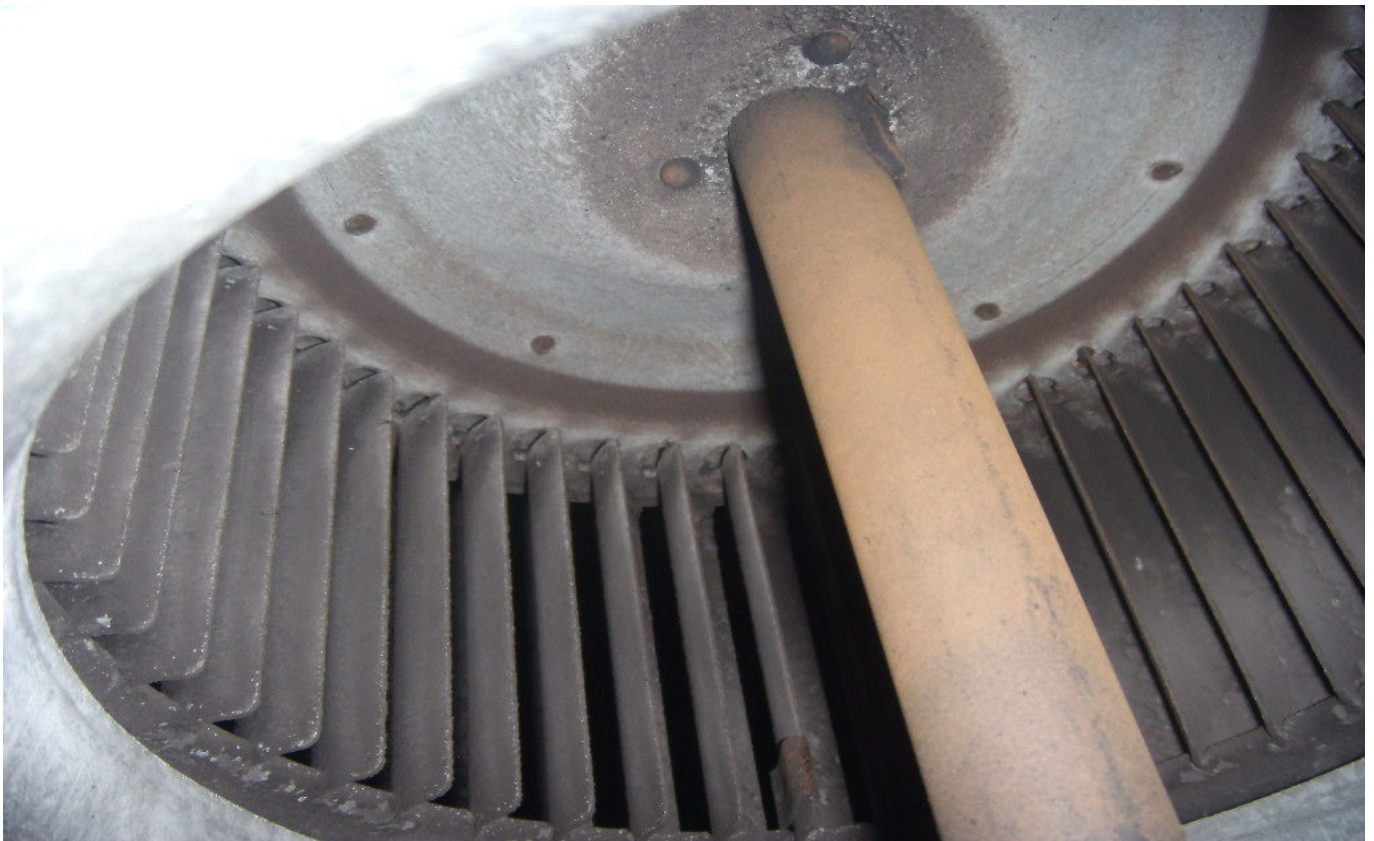
KUVA 6. Yleiskuva poistoilmapuhaltimesta.
