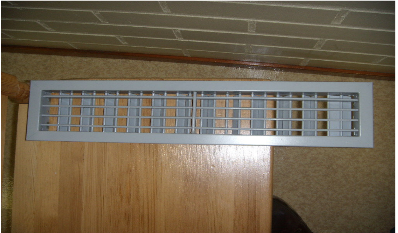
KUVA 11. Yleiskuva huoneiden ns. ritiläsäleiköstä.
