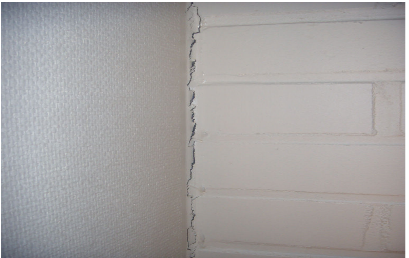
KUVA 14. Yleiskuva päiväkodin rakenteista.
