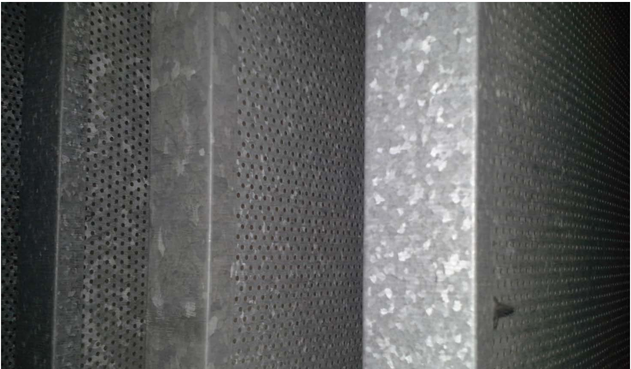
Kuva 8. Tuloilmakoneen äänenvaimennin
