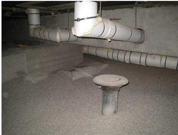
Kuva 9 Alustatilan sepelipinnan alla on suodatinkangas. Keskilinjalla on salaojan tarkastusputkia.
