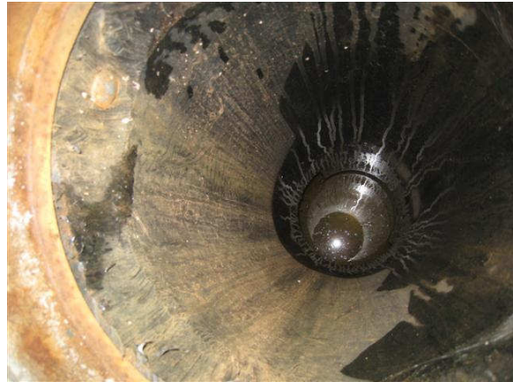
Kuva 2 Tarkastetussa salaojakaivossa vesipinta oli n. 115 cm maanpinnasta.
