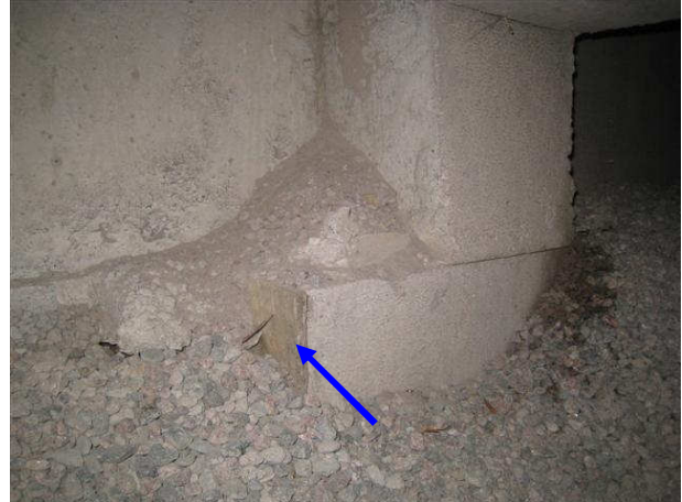
Kuva 26 Vanerimuotti paaluanturan sivulla.
