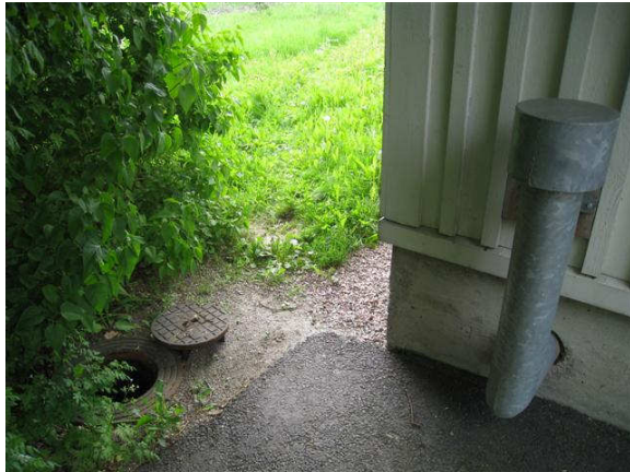
Kuva 1 Tarkastettu salaojakaivo teknisen tilan kulmalla.
