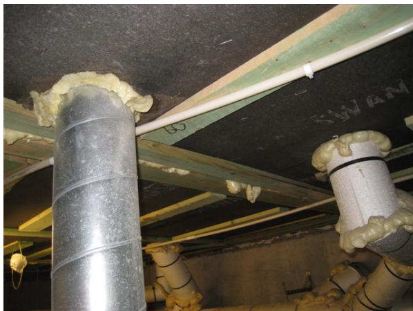
Kuva 17 Viemärien ja poistoilmakanavan juuri-liittymät on tiivistetty.
