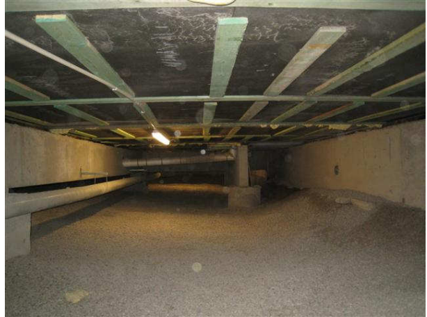
Kuva 10 Alustatilan sepelipinta on pääosin kuiva.
