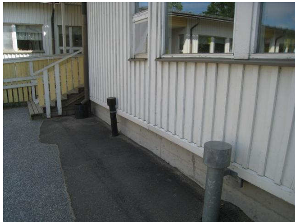
Kuva 3 Tuuletusputkia alustatilaan, joiden juuresta voi päästä vettä, samoin portaiden alta painanteista.
