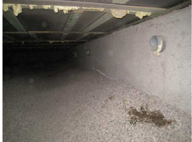
Kuva 14 Tuoreita tippuvesijälkiä tuuletusputken pään kohdalla.
