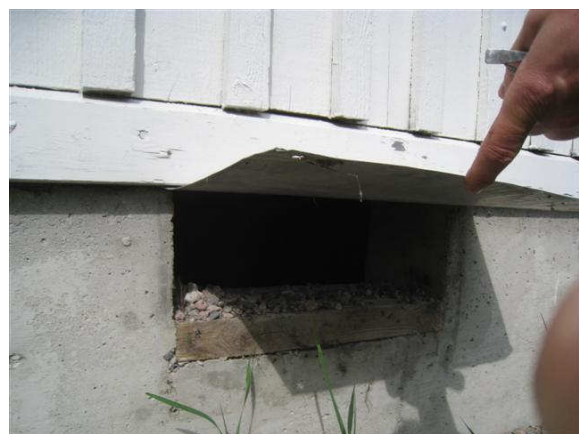
Kuva 4 Pellillä tukittu alkuperäinen alustatilan tuuletusaukko.
