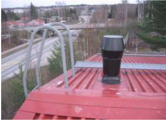
Kuva 11 Talotikkaiden päitä ei ole tuettu ja tikkaiden päästä ei ole lapetikasta kulkusillalle.
