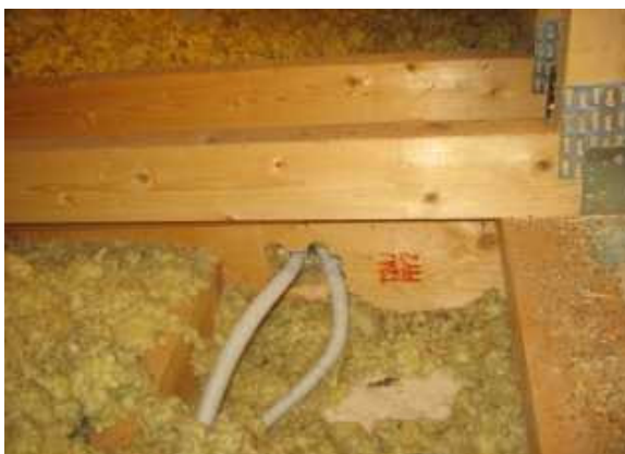
Kuva 9 Eristys on tällä kohtaa vain 2–3 cm ja lähistöllä n. 15 cm. Villan alla on höyrinsulku ja puukipsilevy.
