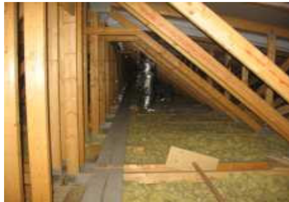
Kuva 2 Yleiskuva yläpohjaontelosta harjalinjalta
