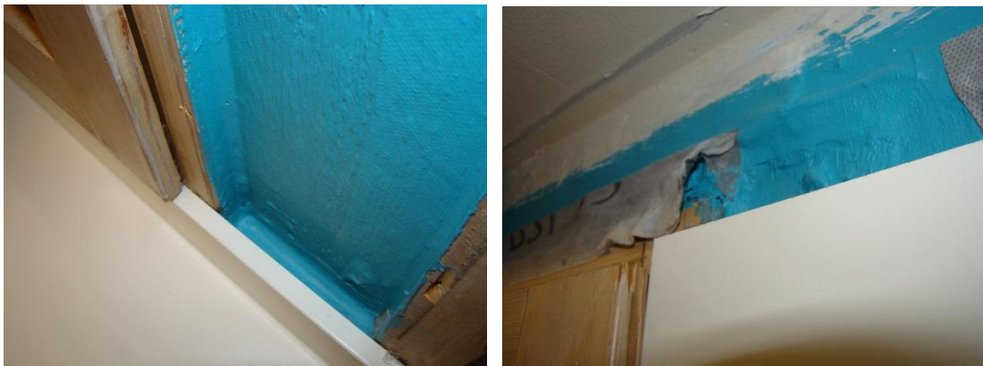
Kuvat 1 ja 2. Vasemman puoleinen kuva on ikkunoiden välisen pystykarmin ja ikkunapenkin liitoksesta. Oikeanpuoleinen kuva on pystykarmin ja ikkunan yläpuolisen vaakakarmin liitoksesta.
