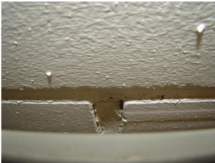
Kuva 5. Kuva on patterin takaa tiilimuurauksesta.
