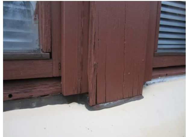
Kuva 12. Ikkunoiden ulkopinta on kärsinyt säärasitusta ja on jo kosteusvaurioita.
