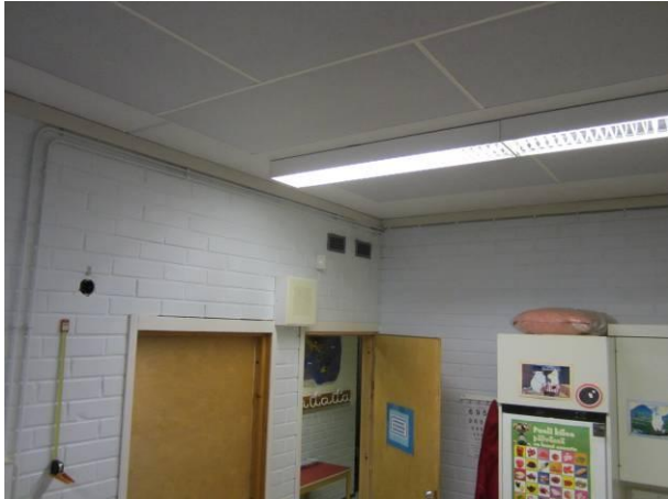
Kuva 13. Ilmanvaihtoelemiä käyttävän puoleisella seinällä.
