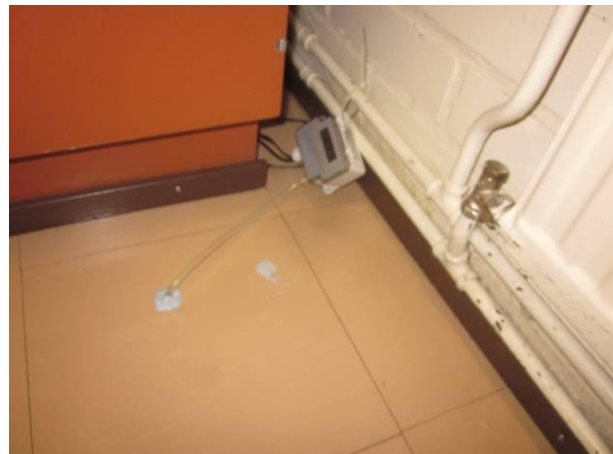
Kuva 16. Mittausjärjestely alustatilaan alapohjan läpi.
