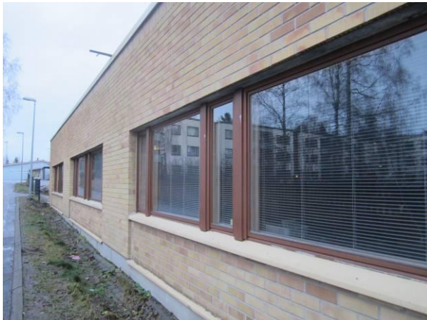
Kuva 11. Yleiskuva julkisivusta. Rakennusvierillä on kallistuspuutteita.
