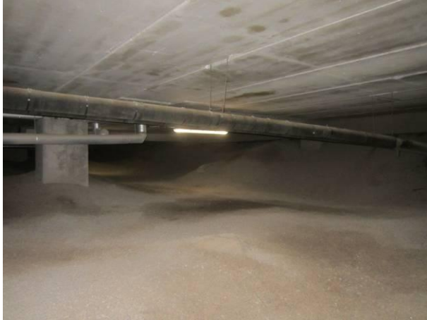
Kuva 9. Yleiskuva alustatiloihin. Kattopintana on styrox-levyt ontelolaattojen alapinnassa.
