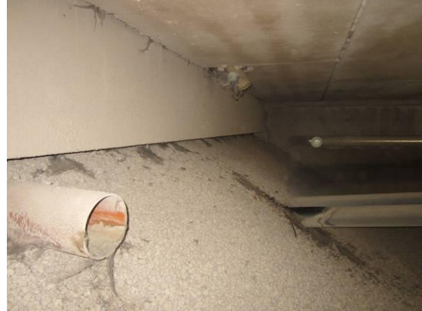
Kuva 10. Korvausilmaputki ulkoseinän perustuspalkin ali.
