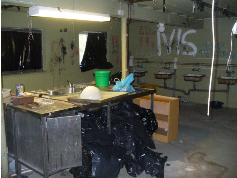
KUVA 10. Viite kohtaan 3.1. Vanhan navettarakennuksen ensimmäisen kerroksen tilaan on rakennettu palkit ja pilarit, jotka kannattavat toisen kerroksen kokoontumistilan puuvälipohjaa ja tukeutuvat kellarin betoniholviin siten, että alapuolella ei ole kantavaa seinä- tai pilarirakennetta. Kuvassa näkyy myös yksi tilan lattiakaivoista paljaalla betonilattialla.
