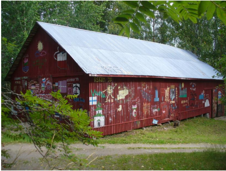
KUVA 15. Viite kohtiin 3.3 ja 3.4. Entisen ladon ja (kuvassa) ja navetan julkisivuissa on vuosikymmenten muistot Kukkonotkossa vietetyistä leireistä, joista osa on ollut kansainvälisiä kokoontumisia
