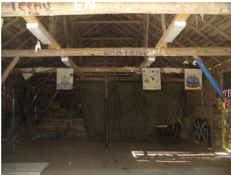
KUVA 14. Viite kohtaan 3.4. Entinen lato on harvarunkoinen rakennus, jonka muoto on antanut paikoin periksi mm. vesikaton osalla. Rakennus on kuitenkin pääosin terve.
