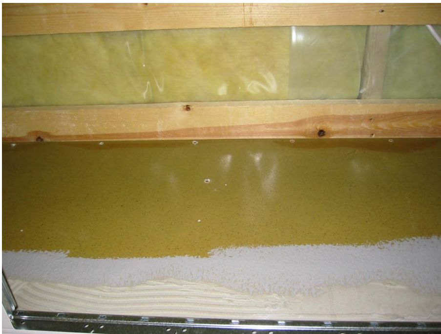
Kuva 2. Huonetilassa 14 alakattorakenteen yläpuolella ei ollut havaittavissa erityisiä vuoto/kosteusjälkiä.
