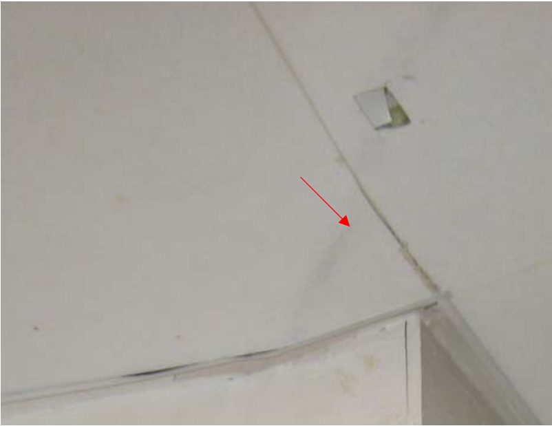
Kuva 16. Huonetilan 23 kattopintaan liittyvän sisäjiirin kohdalla on akustoivan mineraalivillalevyn pinta tummentunut (punainen nuoli), mikä ei kuitenkaan ole merkki rakenteen kosteusvaurioitumisesta vaan vain rakenteen pinnalle taitekohdassa kerääntyneistä epäpuhtauksista (ilmavirtaukset kattopintaa pitkin tartuttavat taitteeseen esim. pölyä).
