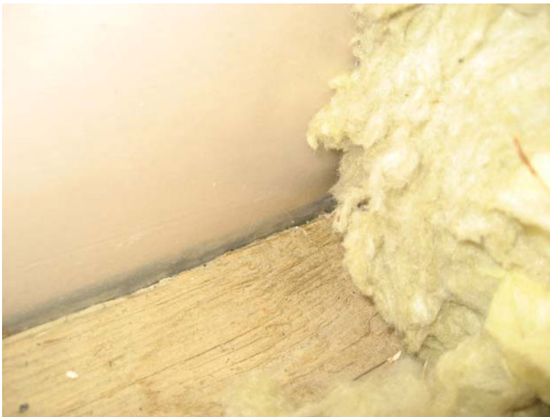
Kuva 5. Rakennusaukoitus AV.02-23. Kuvassa näkyy höyrynsulku ja sisäpinnan kipsilevytys sekä alajuoksun yläpinta, joista ei ollut havaittavissa esimerkiksi vuotoihin viittaavia kosteusjälkiä. Alajuoksun ja kipsilevyn rajakohdassa oleva tumma-alue on höyrynsulun takana oleva liimattu bitumikerminauha, jonka tarkoitus on estää ulkoseinä- ja alapohjarakenteen liitoksessa kosteuden kulku kipsilevyn takaiseen rakenteeseen.
