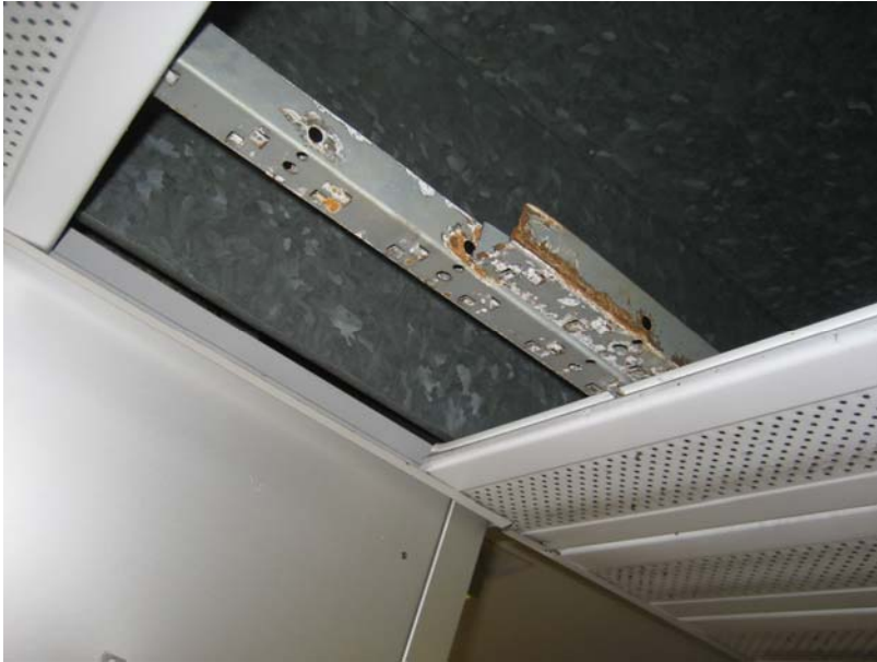
Kuva 11. Rakenneavauskohta AV.04-23. Kuvassa näkyy tuloilmakanavan peltipintoja, joiden puhtaus oli silmämääräisesti arvioiden hyvä.
