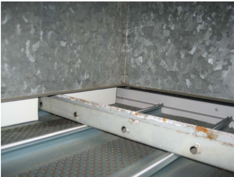
Kuva 12. Rakenneavauskohta AV.04-23. Kuvassa näkyy peltisäleet kanavapuolelta kuvattuna. Säleisiin ei liity mineraalivillaeristeitä ja säleiden pinnalla oli havaittavissa pölyä kanavapeltipintoja enemmän.
