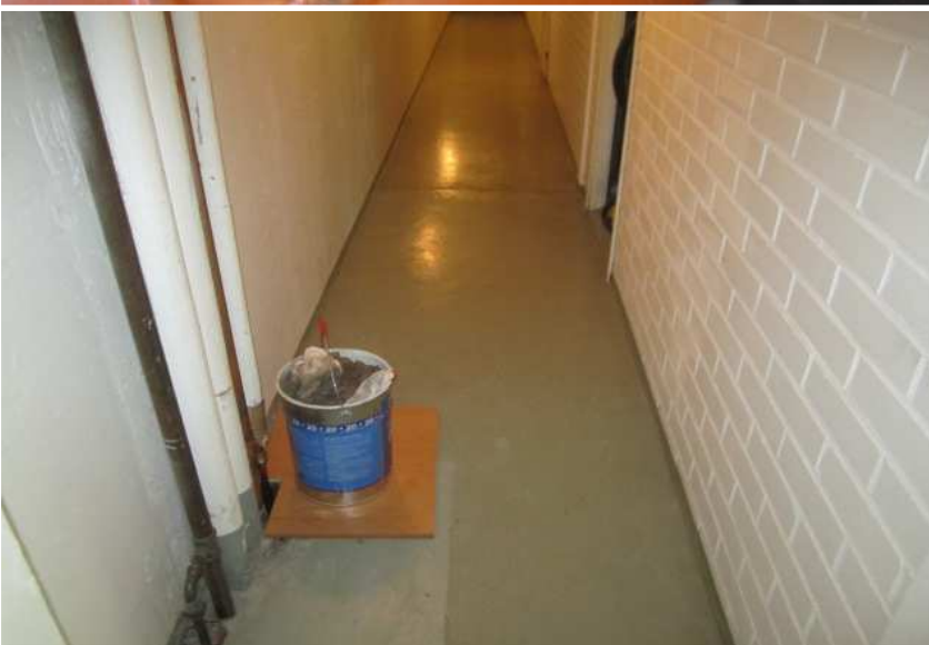
Kuva E- ja F-portaiden välisestä kellarikäytävästä.
