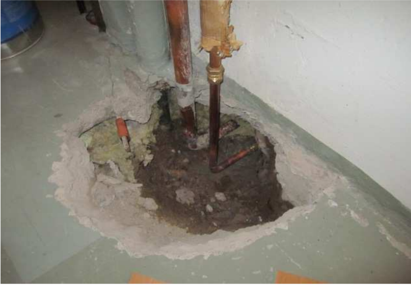
Kuva E- ja F-portaiden välisestä kellarikäytävästä.
