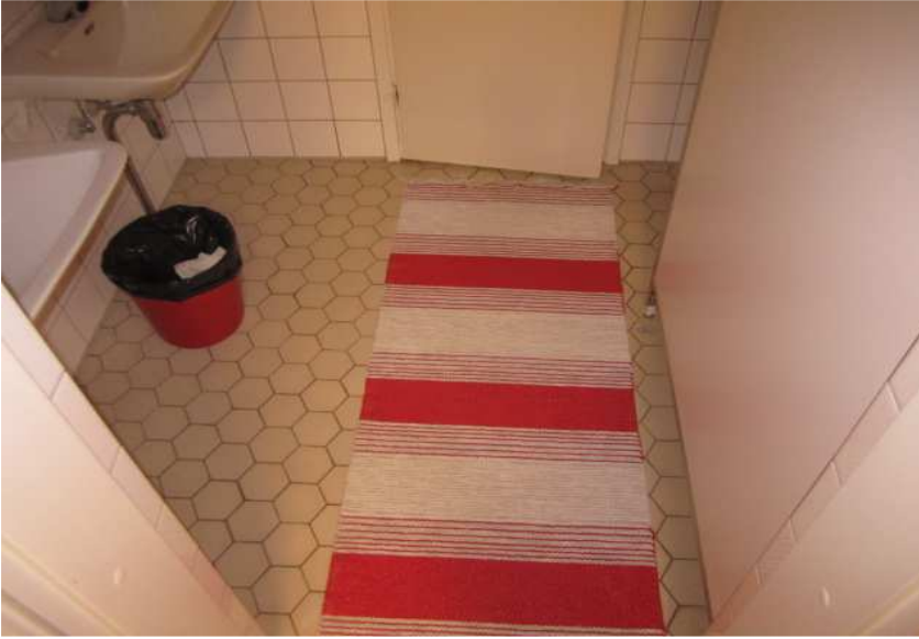
Kuva päiväkodin henkilökunnan pesuhuoneesta.
