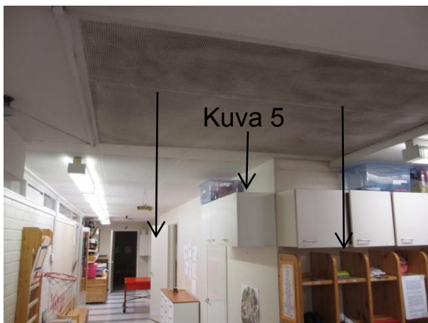
Kuva 4 (Käytävä Sinivuokkojen kohdalla)
