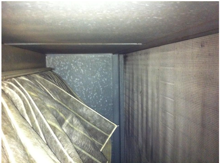
Kuva 3 likainen LTO- patteri.
