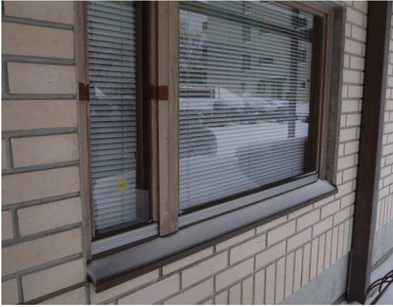
Kohteen ikkunat ovat osin puuikkunoita.
