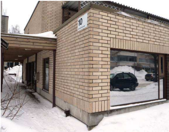
Julkisivut ovat tiilimuurattuja sekä puupintoja.
