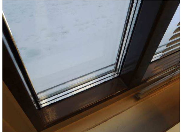
Osa ikkunoista on metallirunkoisia kiinteitä lämpölasielementtejä.
