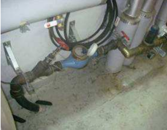
Päävesimittari sijaitsee lämmönjakohuoneessa. Viemäriputket ovat valurautaa että osin muovia
