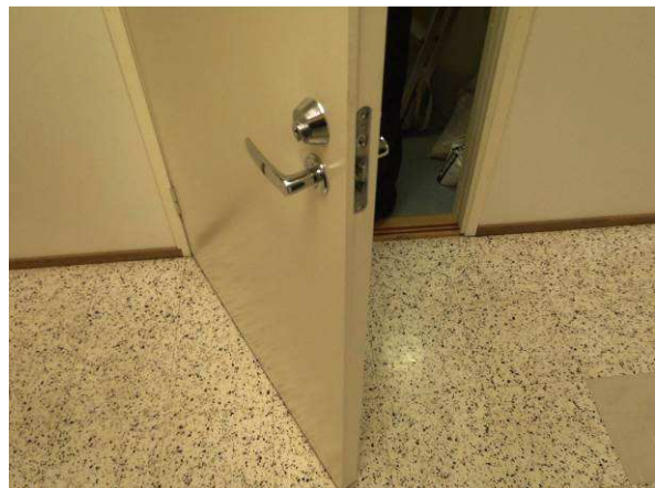
Sisäovet ovat uusittuja, ne ovat vielä hyvässä kunnossa.
