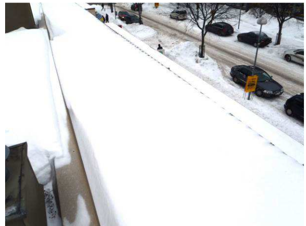
Kuvaa kadunpuolen katon osalta.
