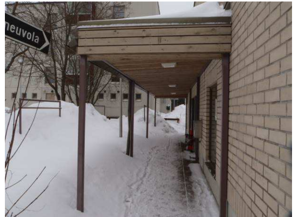
Neuvolan käytävän betonilaatoitus.
