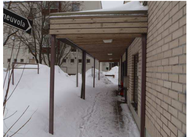
Teräs- ja metallirakenteinen katos.
