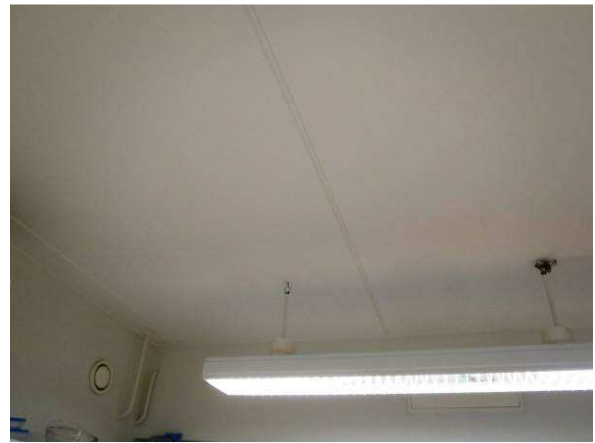
Välipohjan betonilaattoja. Niissä ei havaittu vaurioita.
