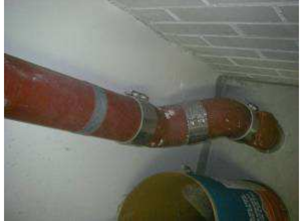
Päävesimittari sijaitsee lämmönjakohuoneessa. Viemäriputket ovat valurautaa että osin muovia
