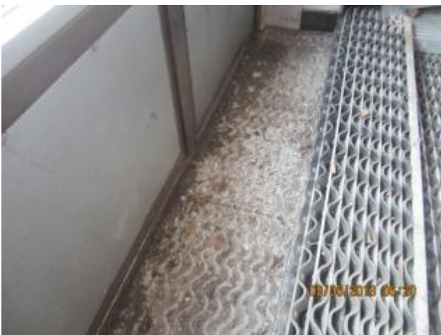
kuva 11 Tuulikaapissa 28 on huonokuntoisia ja irti olevia hovilaattoja.
