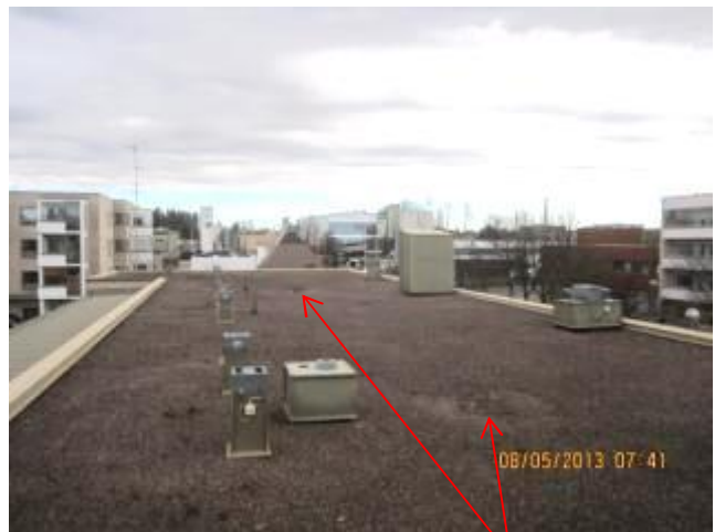
kuva 4 Ylemmän vesikattotason kattokaivot.
