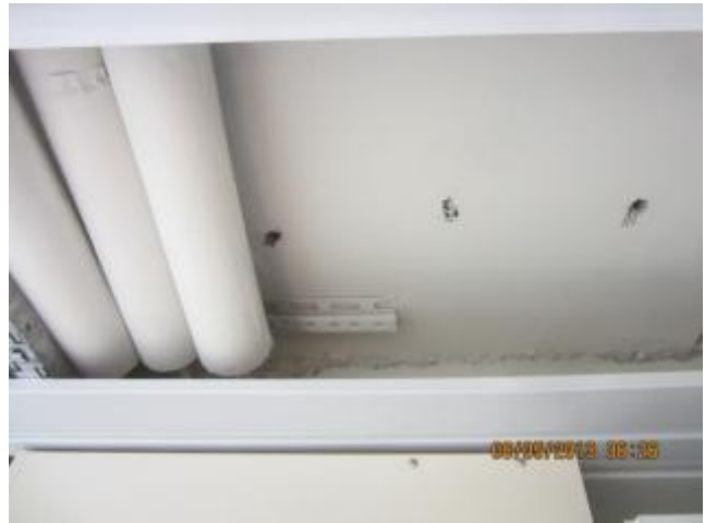
kuva 26 Sälekaton yläpuolella vuotojälkiä ei havaittu. Onteloihin on tehty ilmeisesti vesireikiä.
