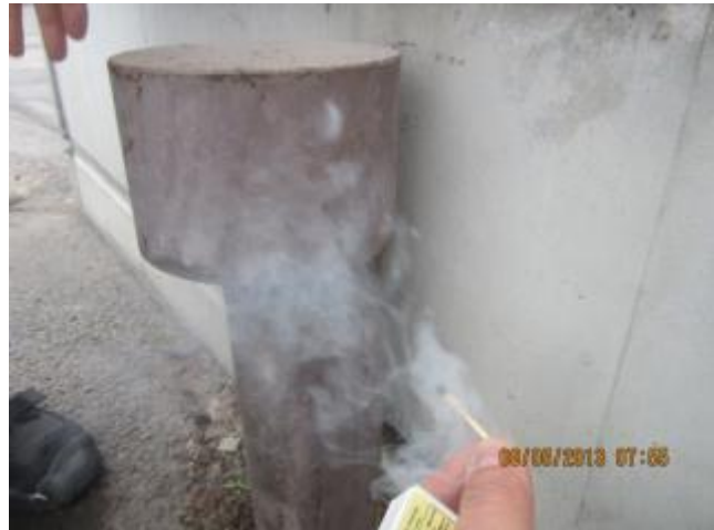
kuva 14 Alustatilan ilmanvaihdon toimivuutta testattiin savulla tuuletusputkien kohdalla.
