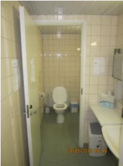
kuva 27 Wc- ja pesuhuonetiloissa on seinissä 15x15 laatat ja latioissa hitsatut muovimatot.
