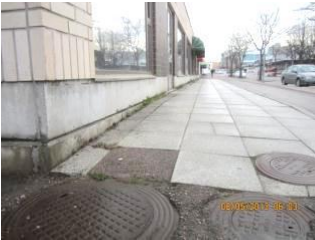
kuva 1 Rakennuksen kadunpuoleiset pintakallistukset ohjaavat sadevedet kohti ajoväylää.
