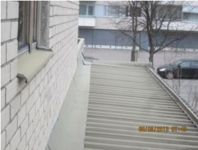
kuva 23 Katoksissa on peltikate.
