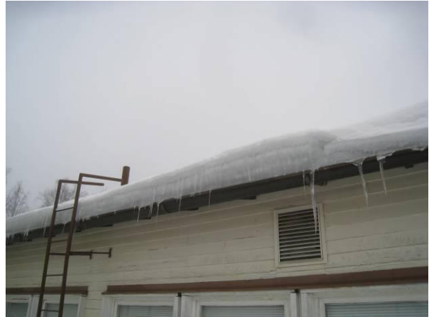
Kuva 8 Jäävirtaa räystäällä 2.2.2011.
