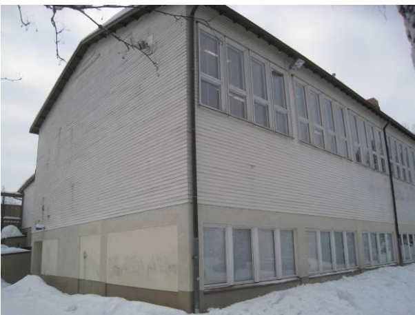
Kuva 23 Yleiskuva itäpäädyistä ja pohjoissivua. Ikkuna-aukkoja on muurattu umpeen.
