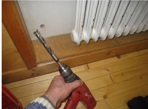
Kuva 44 Rakenneporaus AV5, lastulevy-min.villa 100 mm-tervapaperi,-vinolauta-u.paneeli
