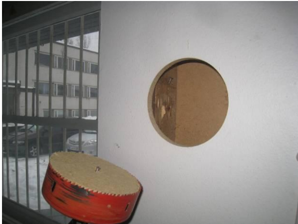
Kuva 31 Rakenneavaus AV3 matalan osan ulkoseinään.
