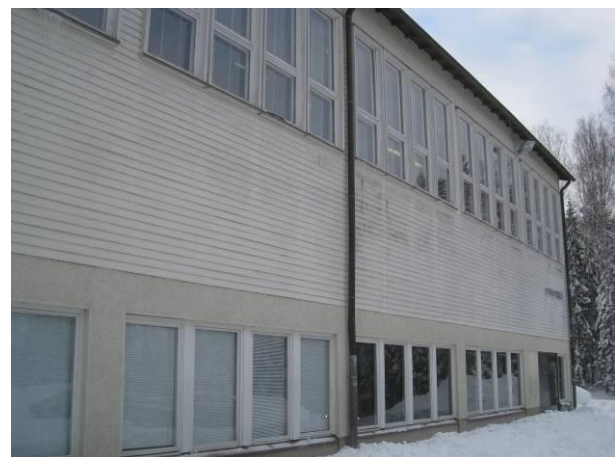
Kuva 24 Pohjoissivua, mikrobikasvua laudoituksen päällä.
