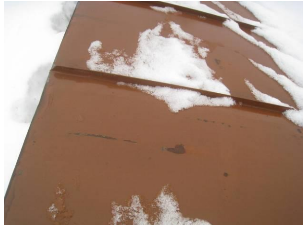
Kuva 2 Kulunut kattomaali.
