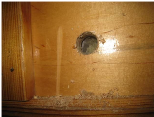
Kuva 45 Rakenneporaus AV6 salin päätyseinään: vaneri-h.sulku-m.villa 100mm-kovalevy-min.villa 100-puu
