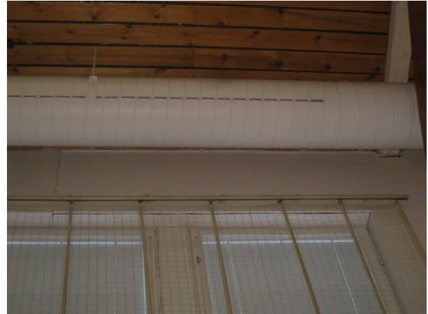
Kuva 34 Salin katon laudoituksenvälistä vaikuttaa pilkottavan alumiinipintainen paperi.
