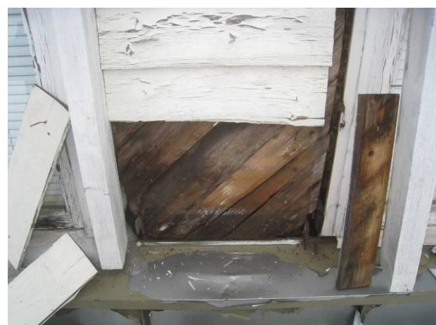
Kuva 12 Rakenneavauskohta AV2 matalan osan vesikaton yläpuolelta, tästä otettiin mikrobinäytteet M1 ja M3.
