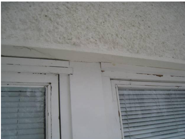
Kuva 29 Tyypillinen pohjakerroksen ikkunan yläosa.
