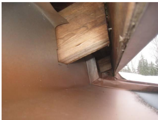
Kuva 5 Harjaratkaisu länsipäädyn lähellä, on jonkinlainen myrskypelti.
