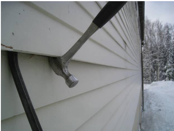
Kuva 27 Pohjoissivun panelin alustan tarkastus tapahtui raottamalla verhouslautaa.
