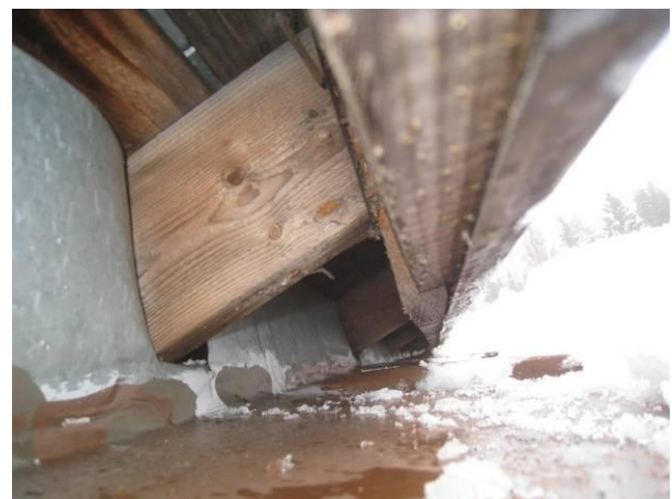
Kuva 4 Harjan ratkaisu itäpäädyssä, ei ole myrskypeltiä, juurinostoa alle 5 cm.
