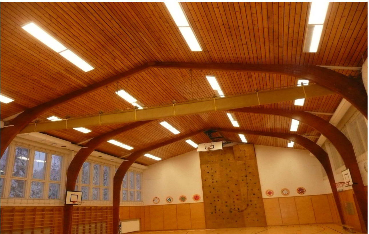
RAK- kuva 4. Liikuntasalin runko muodostuu liimapuisesta kaarirakenteesta.
