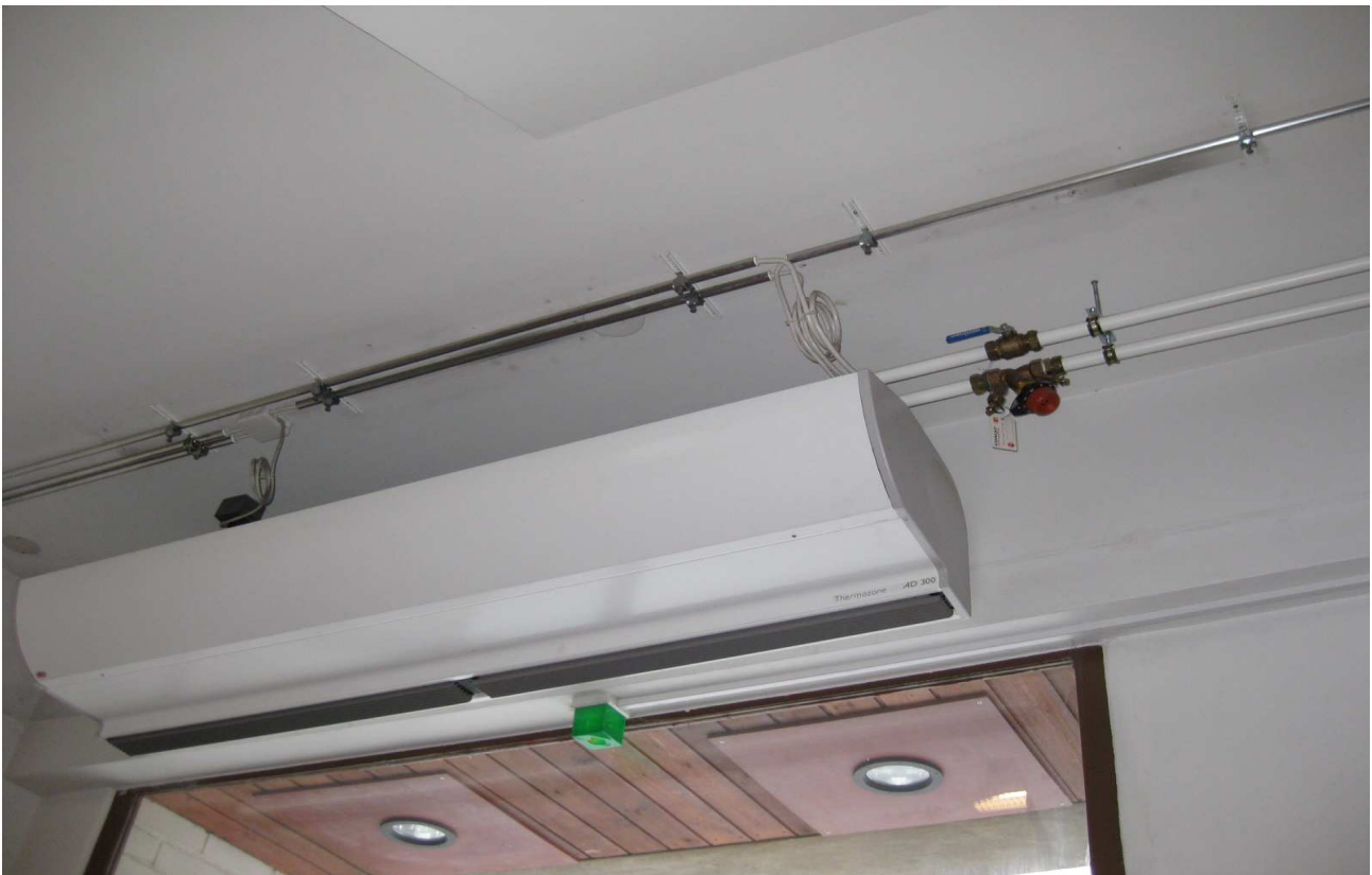
LVI- kuva 13. Koulun uuden puolen tuulikaappia palvelee oviverhopuhallin.
