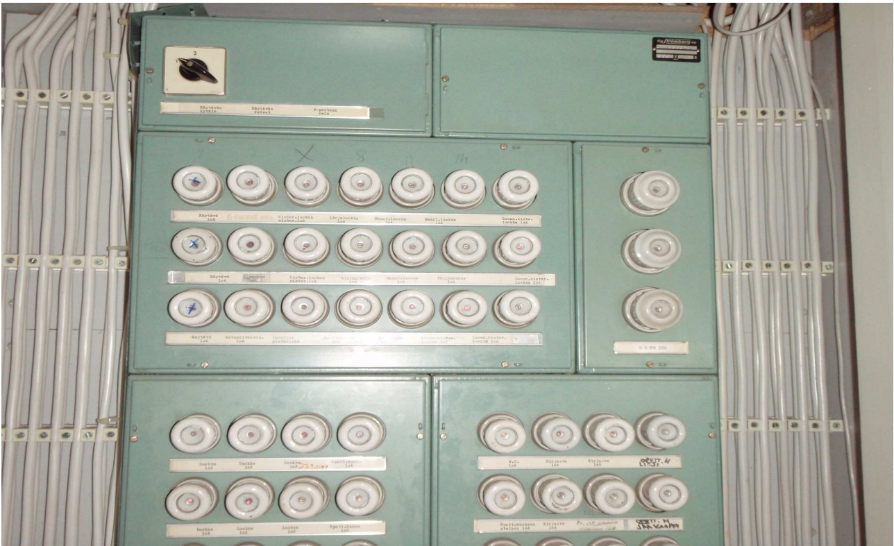
S-kuva 10. Opetustiloja palveleva keskus uudempi rakennus.
