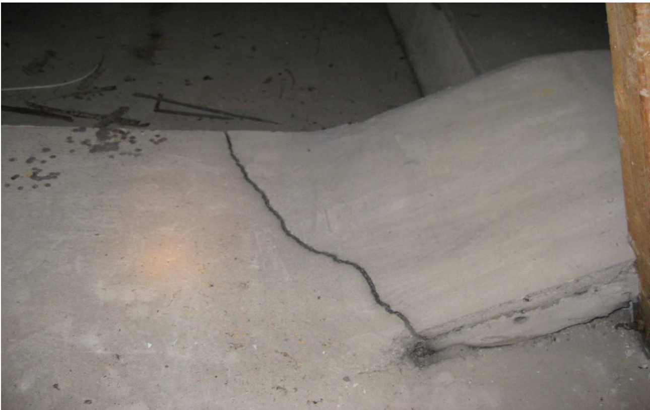
LVI- kuva 19. Yleiskuva koulun päärakennuksen ullakolla olevasta poistoilmakanavasta.
