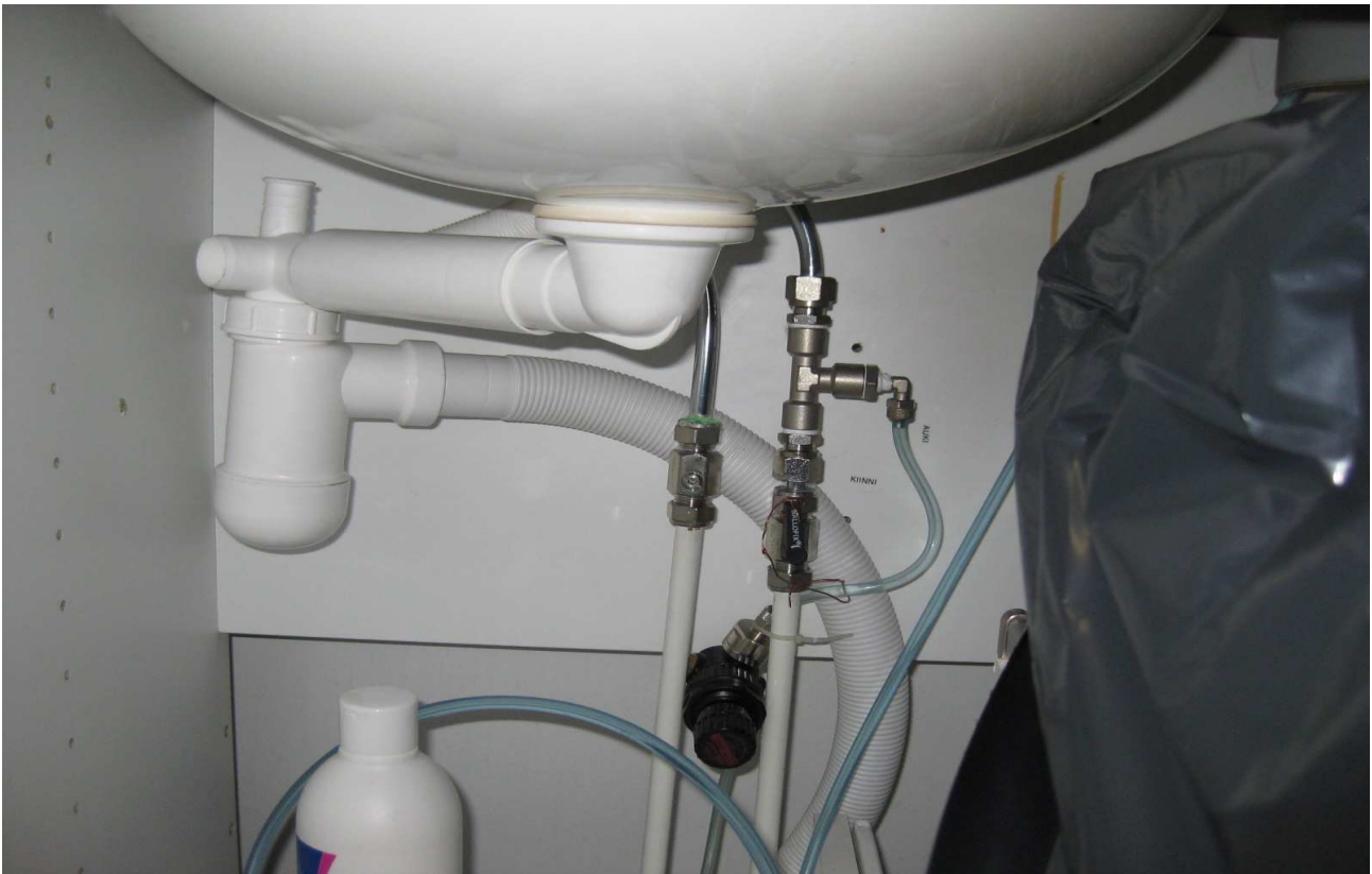
LVI- kuva 12. Yleiskuva hammaslääkärin huoneen pesualtaan kytkennöistä.
