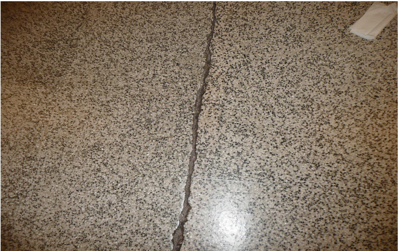
RAK- kuva 13. Mosaiikkibetonilatioissa on vaihtelevissa määrin halkeamia.
