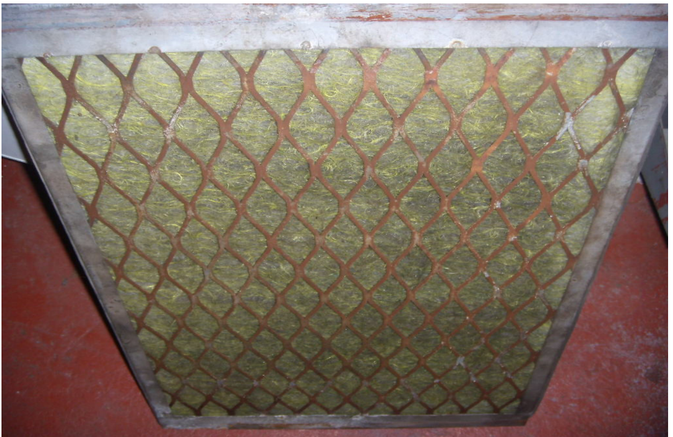
KUVA 6. Yleiskuva tuloilmasuodattimesta LJ-koje 1.
