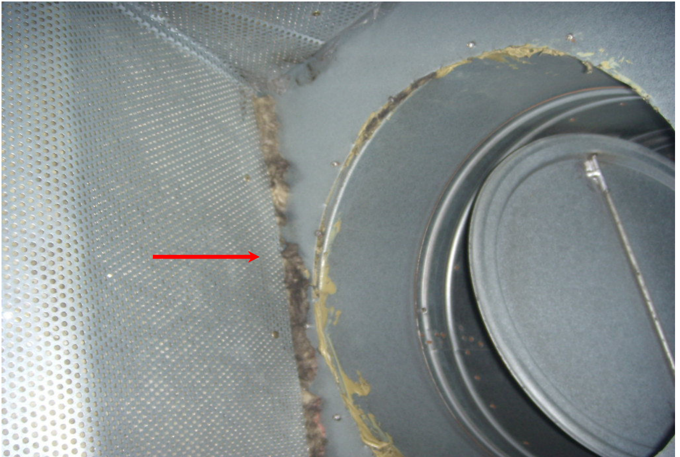
KUVA 16. Yleiskuva tuloilmakammioista 3TK3.
