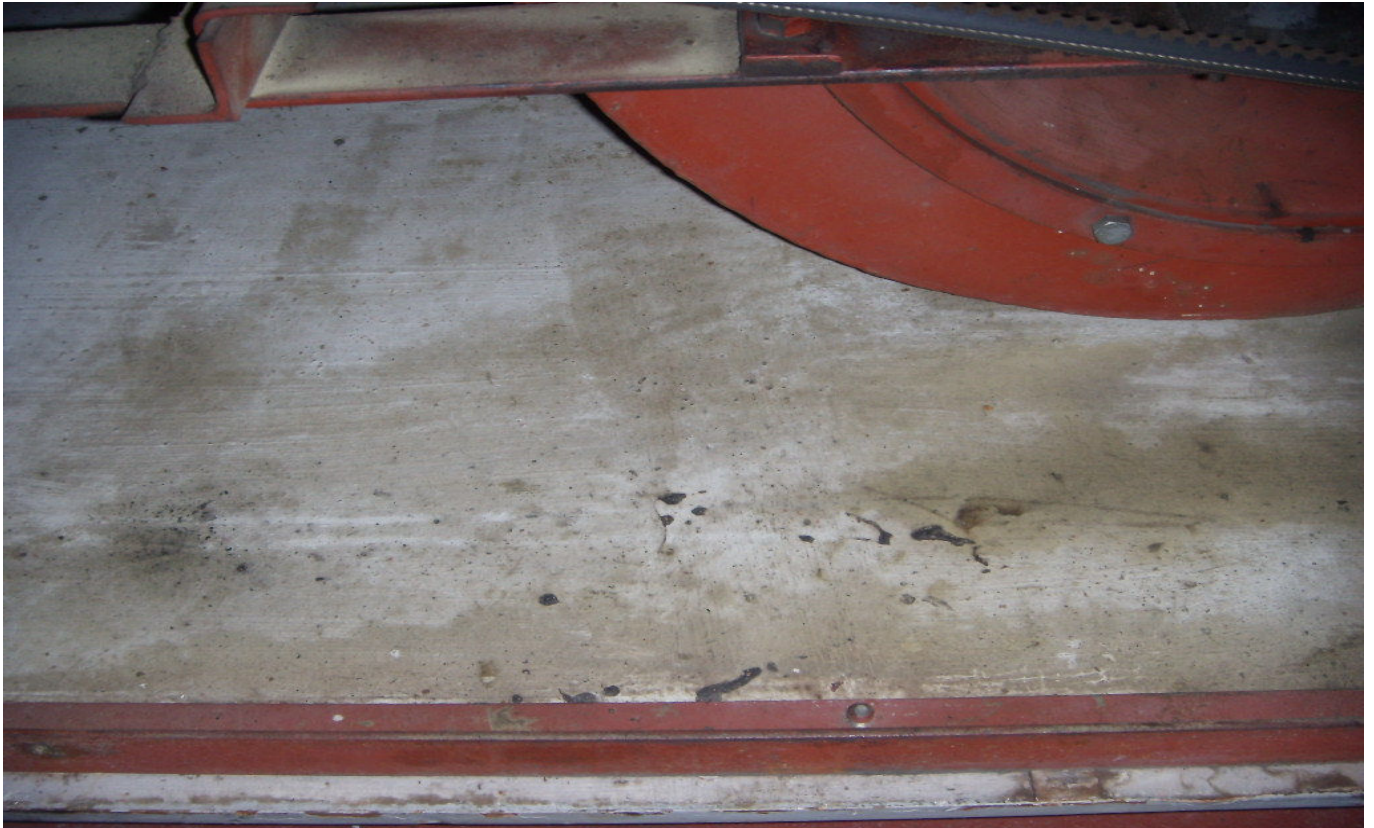
KUVA 9. Yleiskuva tuloilmakammioista LJ- koje 1.
