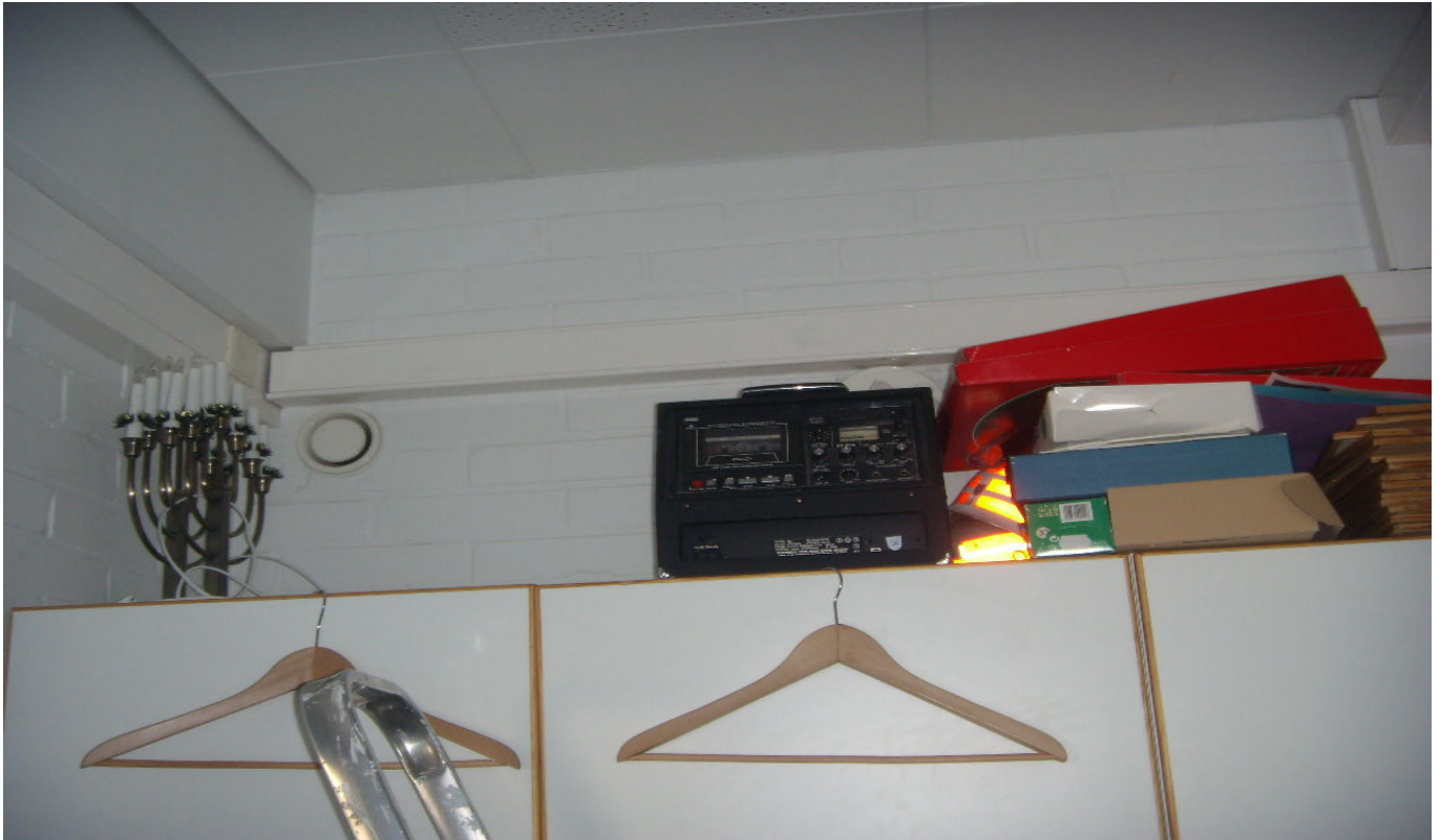
KUVA 29. Opettajien työhuoneen tuloilmaventtiin edessä on paljon tavaraa.
