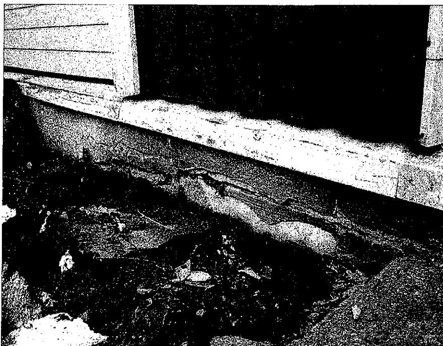
Kuva 7. Rapautunut sokkelirakenne
