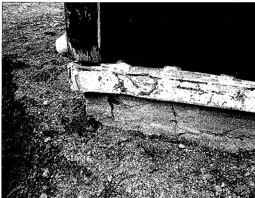
Kuva 8. Rapautunut sokkelirakenne, kolhiintunut sokkelipelti.
