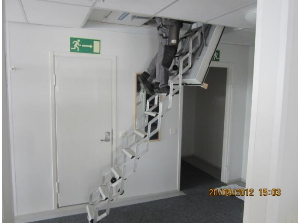
Kuva 43 Kulku toimitilojen yläpohjaonteloon
