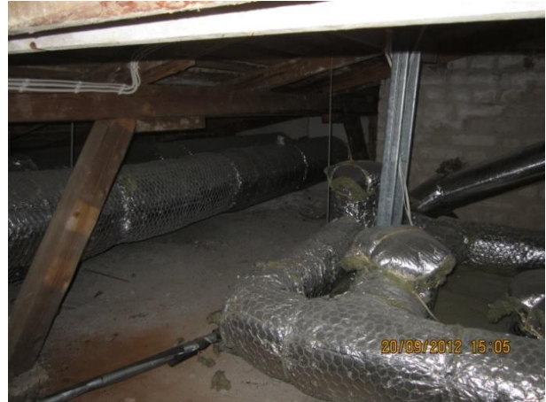
Kuva 44 Toimitilojen yläpohjaa, IV-asennuksia ja betonipermanto
