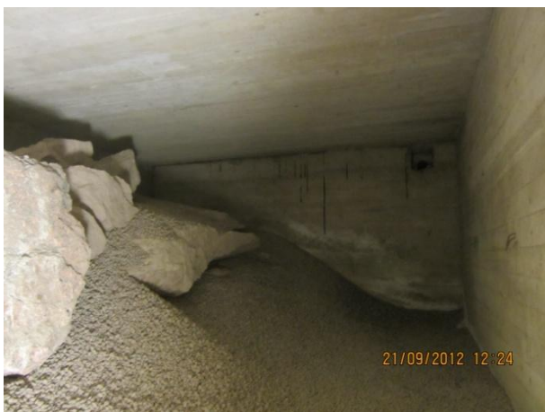
Kuva 11 Kunnostettu alustatila asunnon 2 alla.
