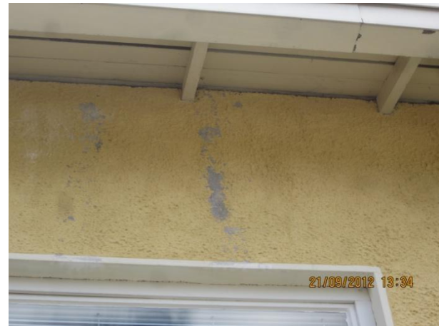
Kuva 22 Maali irti toimitilaosan itäsivun räystään alla.
