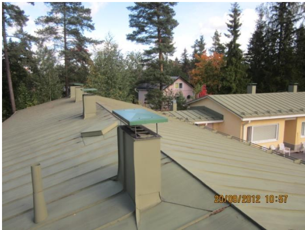
Kuva 33 Yleiskuva asunto-osan vesikatolta, kulkusiltoja ei ole.
