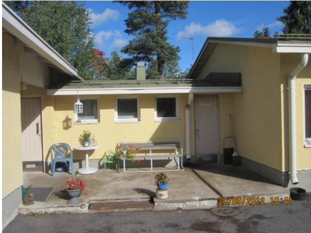
Kuva 25 Nivelosalla on kh-kivimuuraus, pääsisäänkäyntien yläpuolella on puuverhous
