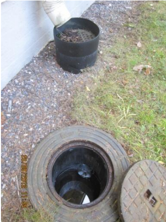
Kuva 19 Tarkastuskaivo asunnon 5 kohdalla johon salaoja päättyy, mp-jp 0,6 m
