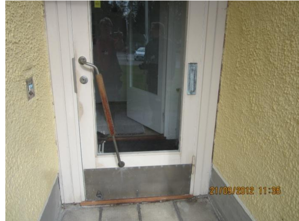
Kuva 32 Asuntojen ovissa on vain yksi lasi, eikä ole tiivisteitä.
