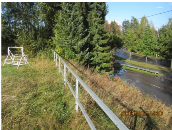
Kuva 5 Itäsvun suoja-aita jyrkän luiskan laidalla
