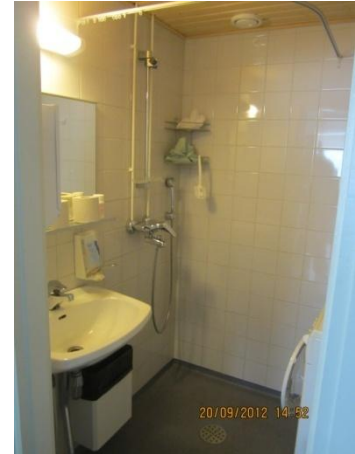
Kuva 62 Toimitilojen 1. krs:n wc-tila, uudet kvv-asennukset ja koneell. ilmanvaihto
