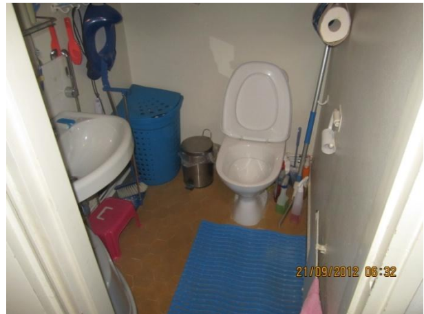
Kuva 46 Asunnon wc-tila, alkuperäisiä laatoituksia
