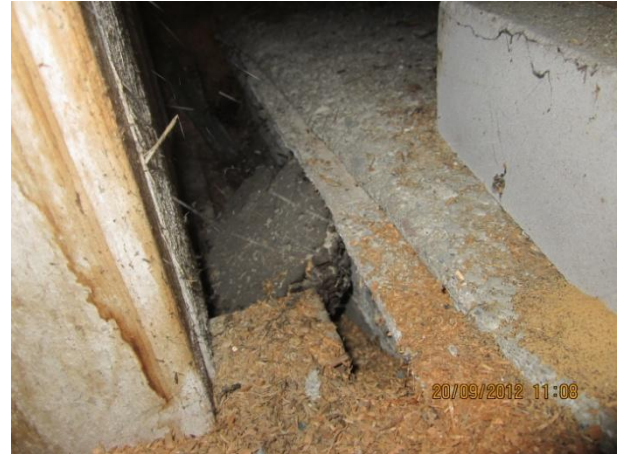
Kuva 38 Autotallin yläpohjassa on tojalevyeriste, rajalla on myös korkieristettä
