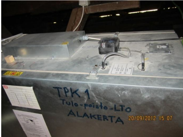
Kuva 61 Toimitilaosin IV-koje
