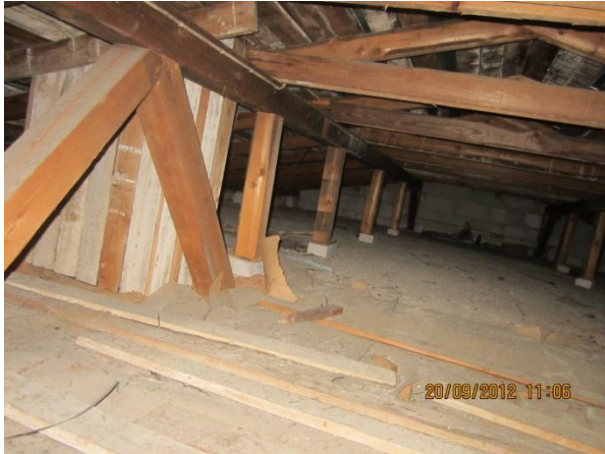
Kuva 37 Asunto-osan vesikaton rakenteita, puu- ja betonirakenteista yläpohjaa
