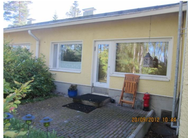
Kuva 2 Asunnon terassi, talotikkaat vesikatolle
