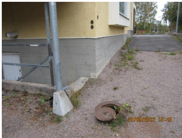
Kuva 15 Salaojan tarkastuskaivo toimitilaosan nurkalla, josta lähtee purkuputki.
