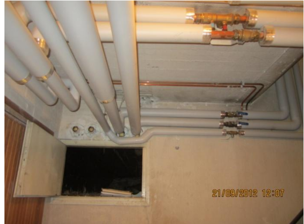
Kuva 56 Uusia putkia ja putkikanaali alapohjan alle.
