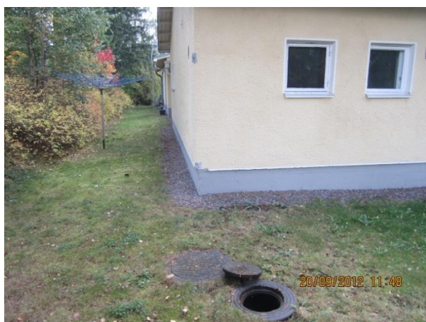
Kuva 17 Salaojan tarkastuskaivo saunan nur- kalla
