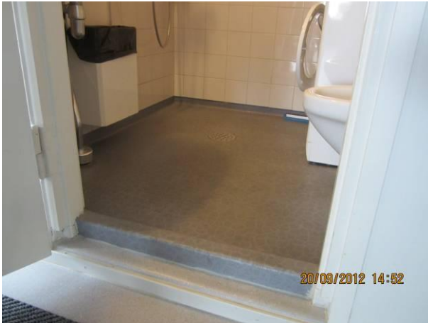
Kuva 25 Toimitilojen wc-suihkuhuone on hyvässä kunnossa.
