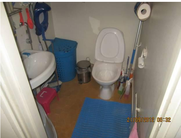
Kuva 21 Asunnon wc-tila on nk. kuiva tila, vaikka onkin käsisuihku.
