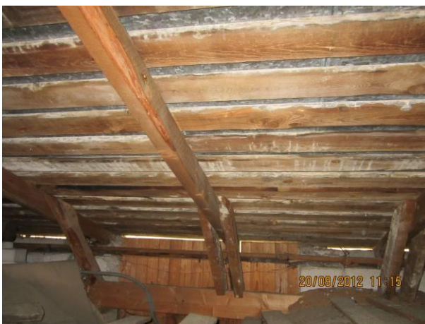
Kuva 19 Vesikatealusta on terveen värinen, ontelo tuulettuu räystäältä.
