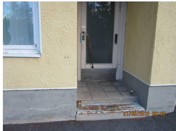
Kuva 16 Pääovet ovat katoksen suojaamat.
