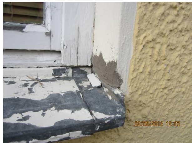
Kuva 12 Huono pellitysliittymä.
