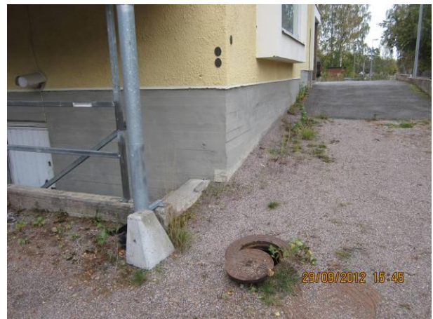
Kuva 6 Toimitilanurkalla purkukaivo
