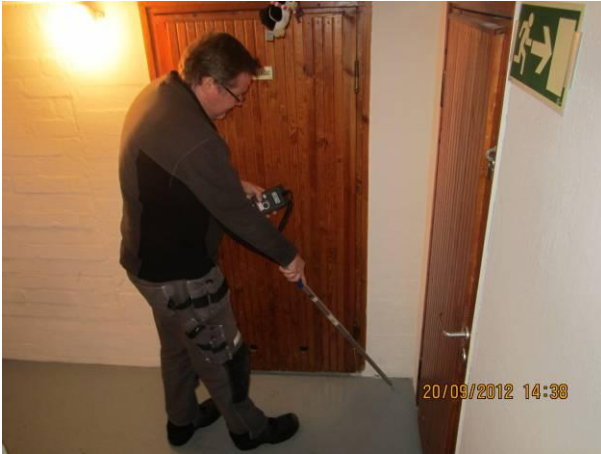
Kuva 9 Pintakosteus koholla kellarikäytävällä pääportaan lähellä.
