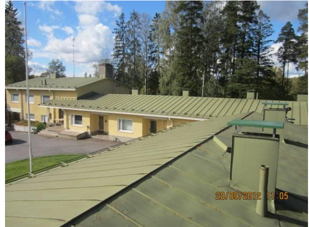
Kuva 18 Yleiskuva autotallien kohdalta
