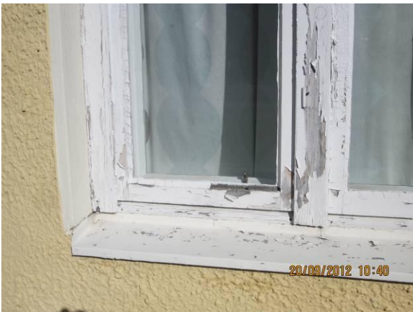
Kuva 15 Tyypillinen ikkunavaurio.
