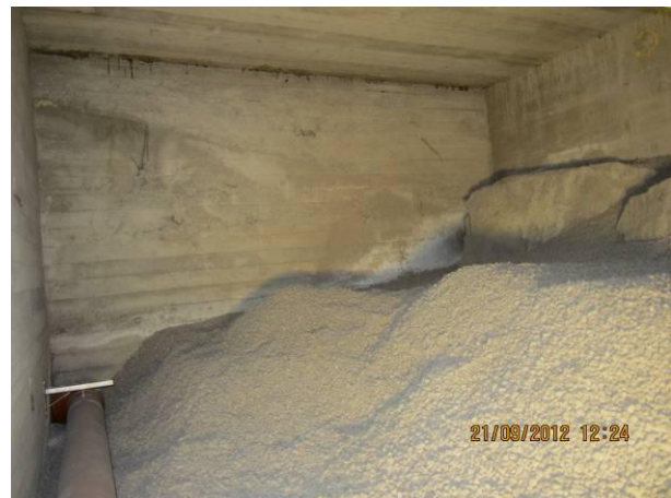
Kuva 8 Alustatila asunnon 3 alla on kunnostettu.
