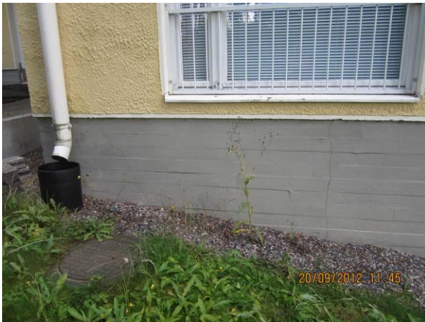
Kuva 3 Sokkelin halkeama
