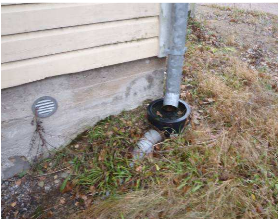
Laajennus osalla on betonisokkeli.
