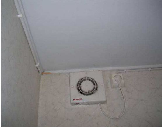
Alakerran wc-tilaan on lisätty poistopuhallin.
