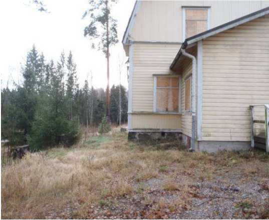
Kuvaa rakennuksen tien puolelta, maanpinta kallistaa pois rakennuksesta
