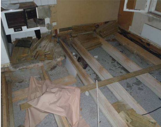
Purettu alakerran laajennusosan lattia.
