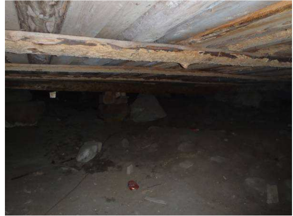
Kuvaa alapohjasta vanhan osan alta, jossa puurakenteet ovat osin luonnonkiviä päällä.
