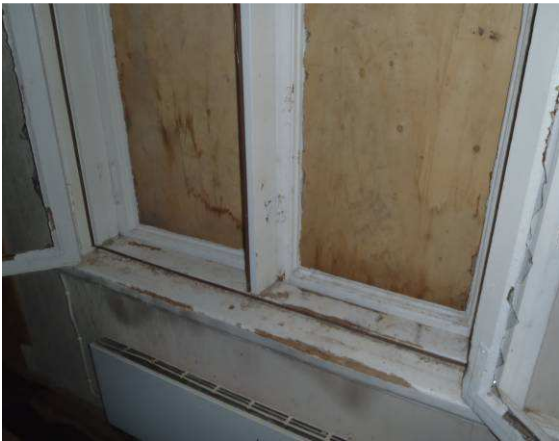
Yleiskuvaa rakennuksen ikkunasta, ne on peitetty ulkopuolelta vanerilevyin.
