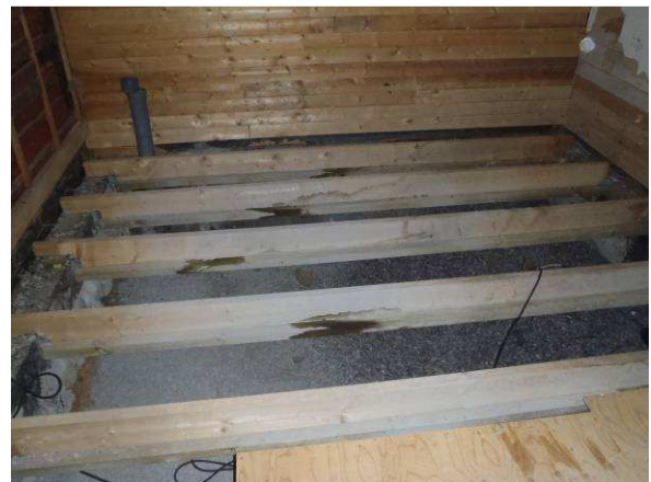
Kuvaa laajennusosan avatusta lattiarakenteesta, joiden korjaustyöt olivat kesken.
