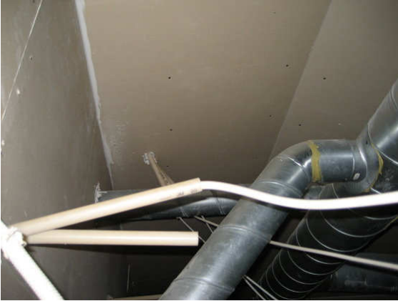
Kuva 15 Alakattojen yläpuolelle tähystettiin tarkastusluukkujen kautta.
