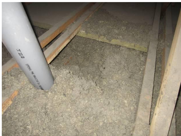
Kuva 15 Eristeessä oleva potero.
