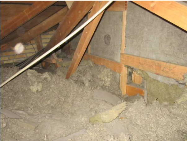
Kuva 23 Tekninen tila 19 kohdalla Työtila 20 seinää, villoja on tallottu.
