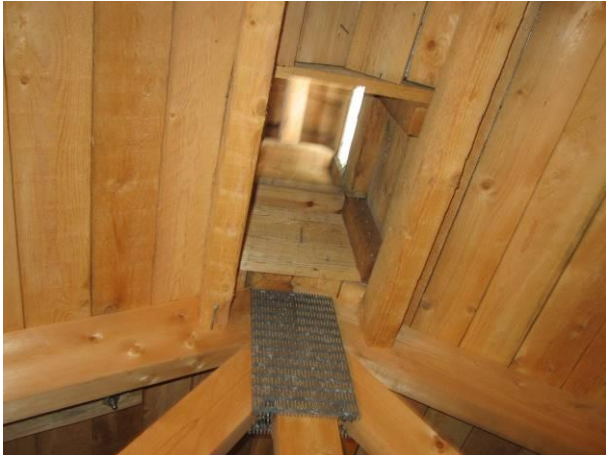
Kuva 11 Yläpohjaontelon tuuletuspiippu
