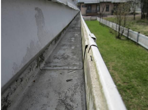
Kuva 27 Räystä ja räystäskouru vaikuttivat olevan kunnossa.
