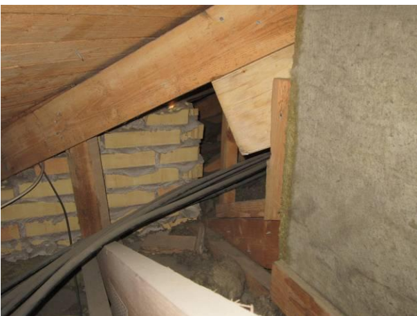
Kuva 23 Tekninen tila 19 kohdalla Työtila 20 seinää, villoja on tallottu.
