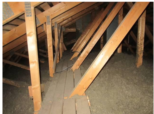
Kuva 24 Eristepuutteita työtila 20 seinässä ja tekninen tila 19 yläpohjassa.
