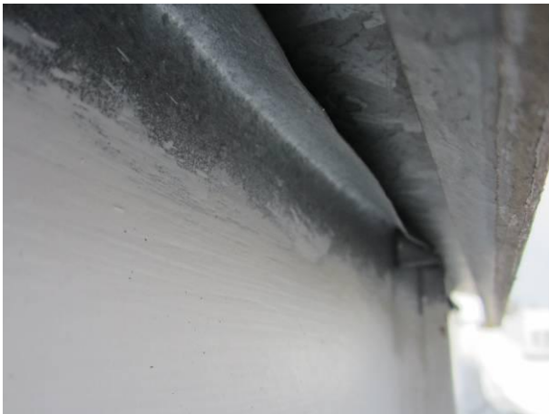
Kuva 39 Juurinoston tuuletusreitti on heikko.
