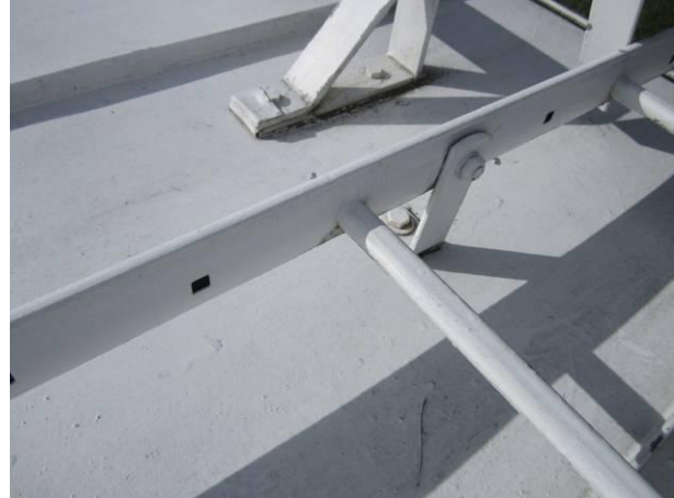
Kuva 28 Lumiesteet ja lapetikkaat on kiinnitetty läpikulkein.
