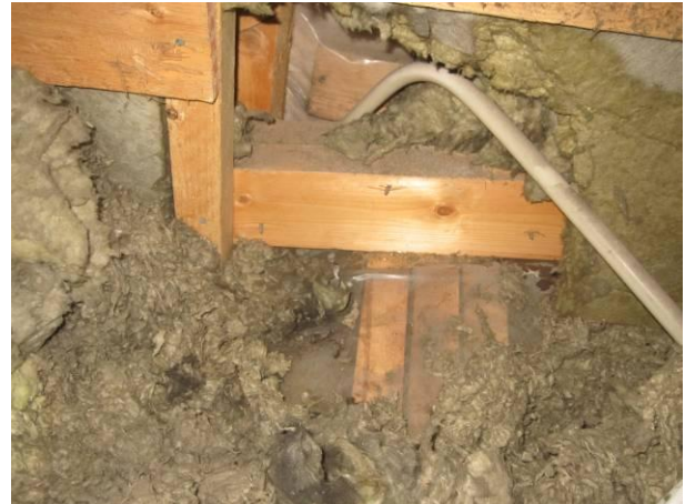
Kuva 24 Eristepuutteita työtila 20 seinässä ja tekninen tila 19 yläpohjassa.
