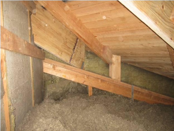
Kuva 21 Vasemmalla Työtila 20 seinää ja vaatetila 24 yläpuolinen ontelotila
