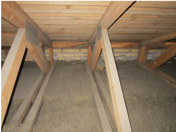
Kuva 13 Kunnossa oleva eristys
