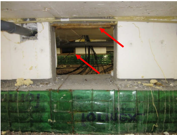
Kuva 1 Kulkuaukkojen valunaikaiset kehyspuut ovat paikoin jäljellä. Anturassa Formex-järjestelmä.
