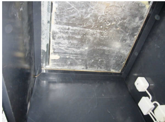
Kuva 6 Lohkon 1 käyntiluukku. Luukut ovat eristetty alapinnasta.
