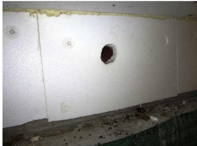
Kuva 8 Lohkon 6 tuuletusputken perusmuurin läpivienti.
