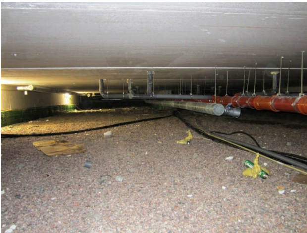
Kuva 13 Lohkoissa rakennusaikaista jätettä.
