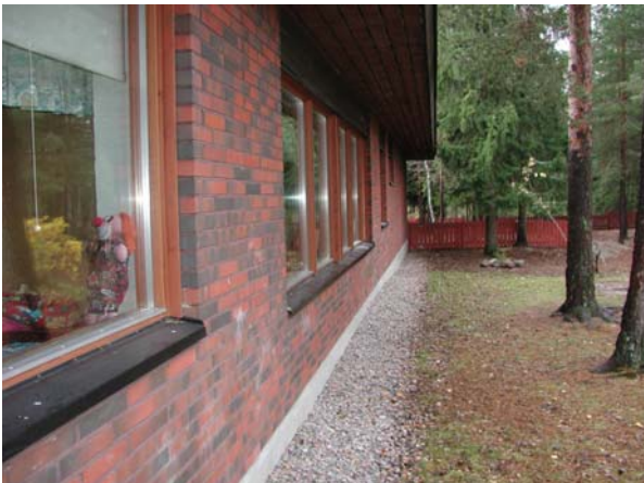
Kuva 2. Ikkunat ja tiiliseinät ovat yleisesti hyväkuntoiset ja seinän vierellä on sepeli.
