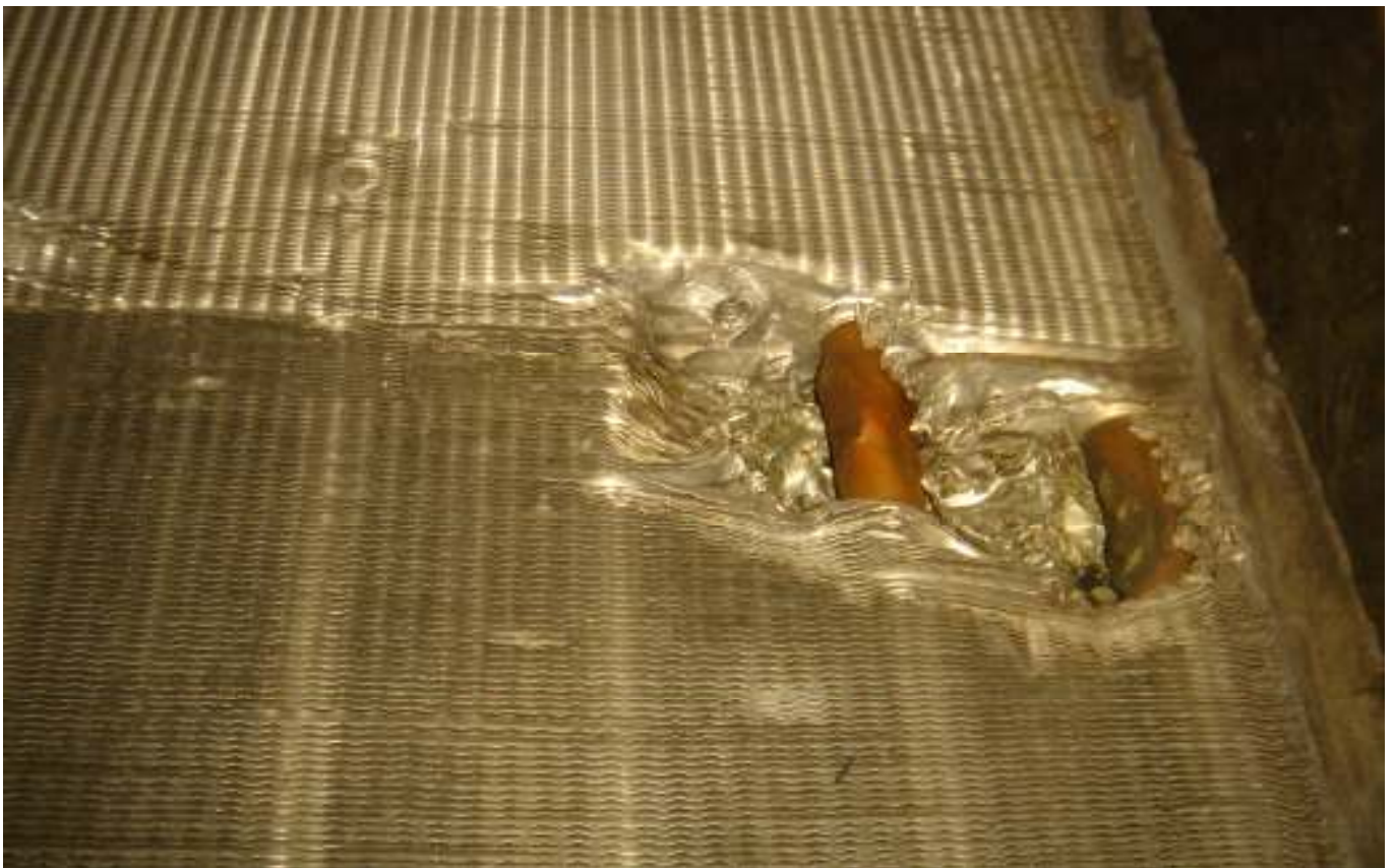
KUVA 12. Lämpöpatteria on paikattu ja patterin kolhuja tulisi kammata auki.
