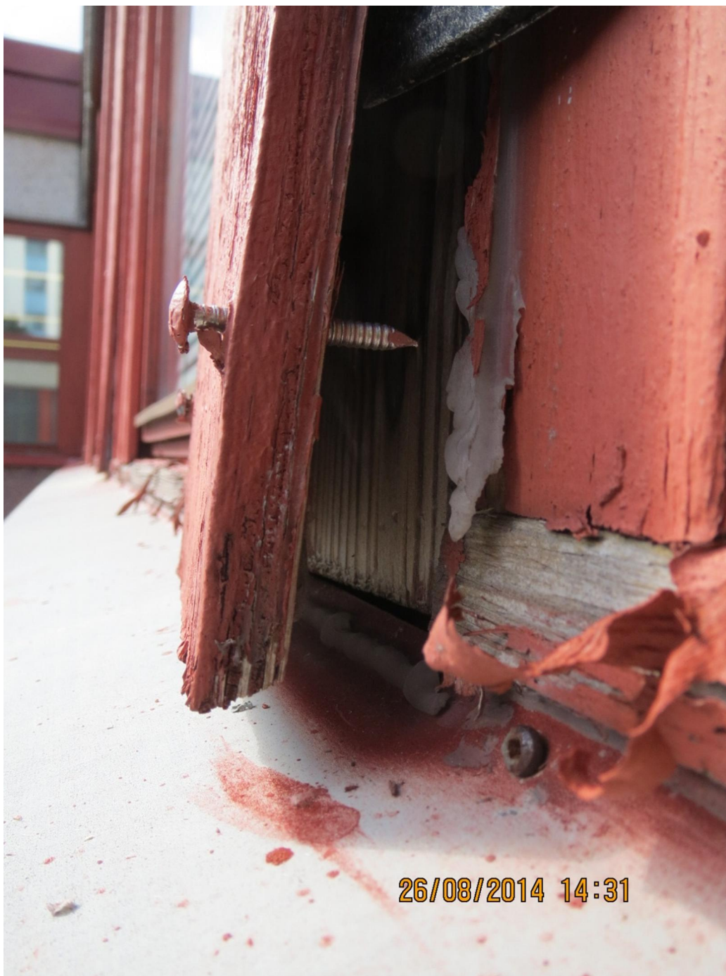
Kuva 6: ikkunoiden välin peitelevy ja vesipellin matala ylösnosto
