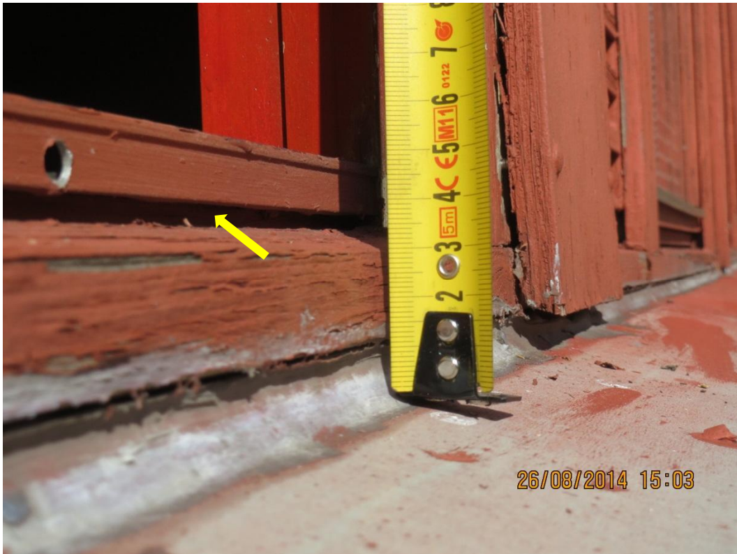
Kuva 9: vesipellin ylösnosto
