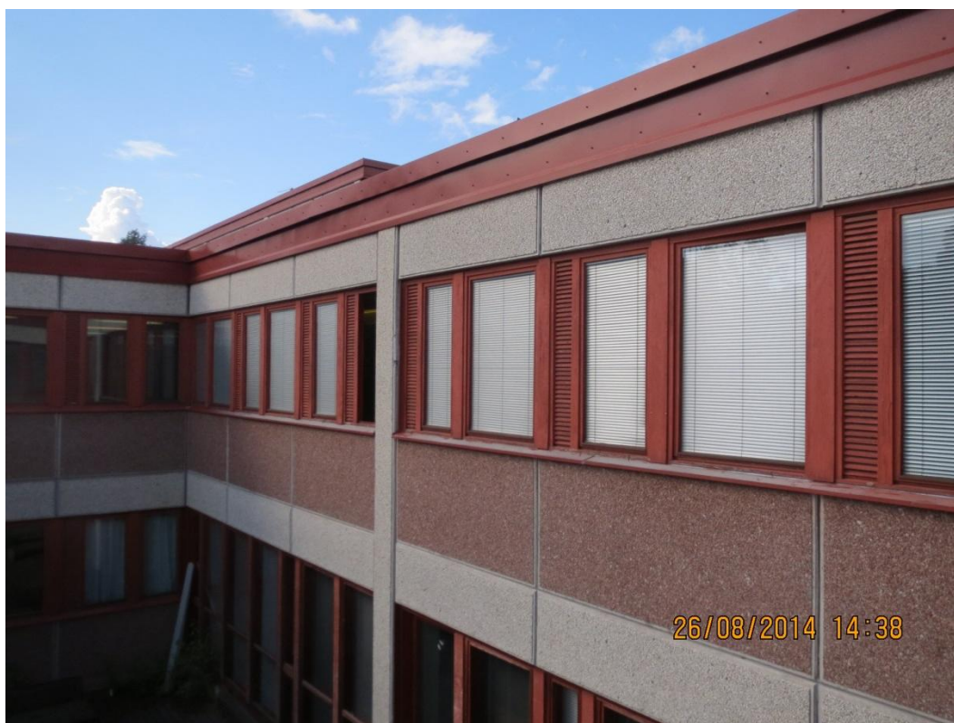
Kuva 7: julkisivua kyseiseltä kohdalta
