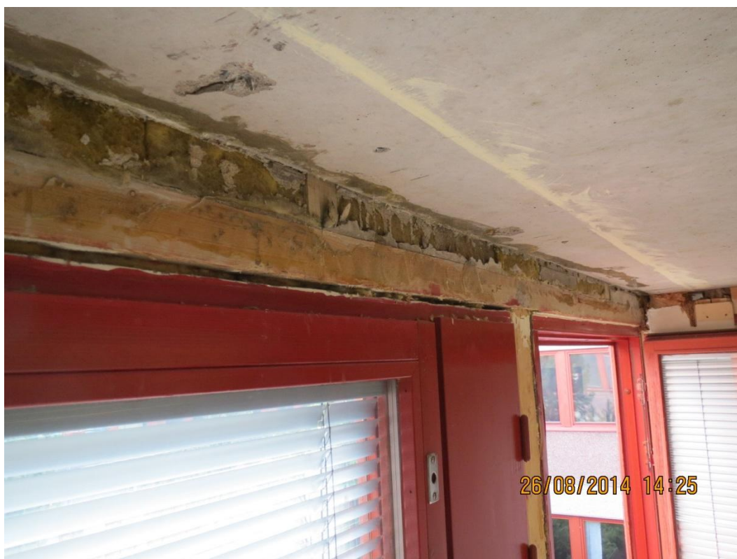
Kuva 2: ikkunan yläreunan liitos
