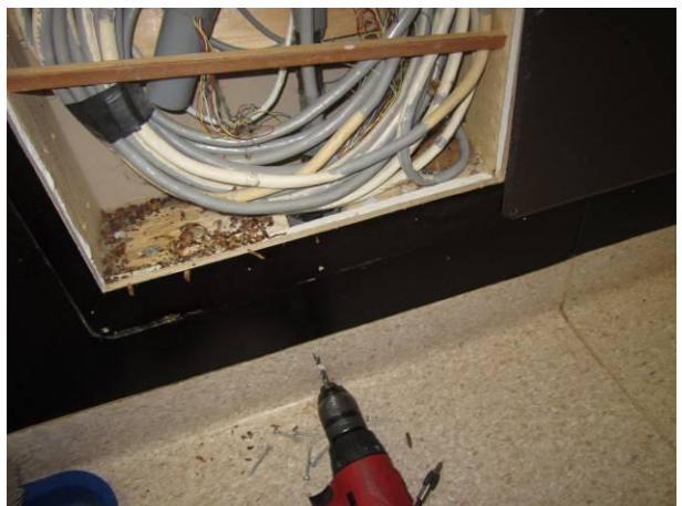
Kuva 18 Ilmavuotoreittejä sähköputkista.
