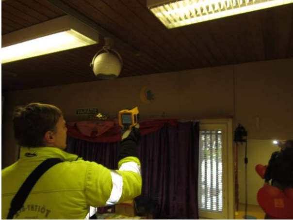
Kuva 25 Lämpökameralla havaittiin ilma-/ lämpövuotoja
