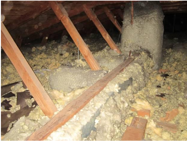
Kuva 21 Yläpohjaontelo, eristevikoja.
