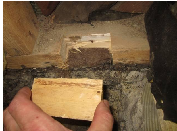
Kuva 16 RA2 -avaus, puu oli tervettä.
