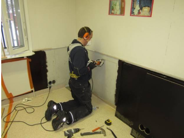
Kuva 13 "Keittiön" nurkkaan tehtiin avaus RA2.
