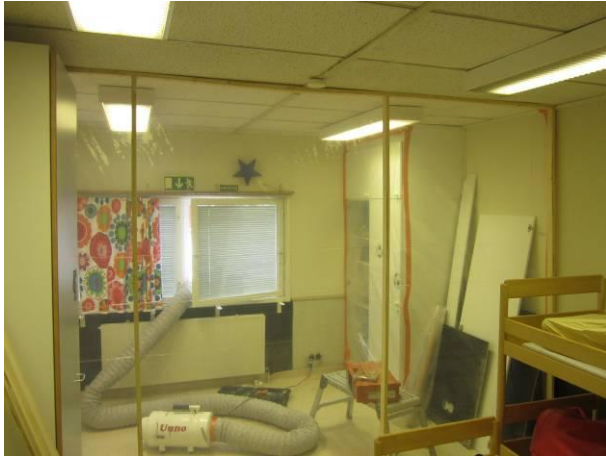
Kuva 9 Osastointi ja alipaineistus "nukkari"-huoneessa, johon avaus RA1.
