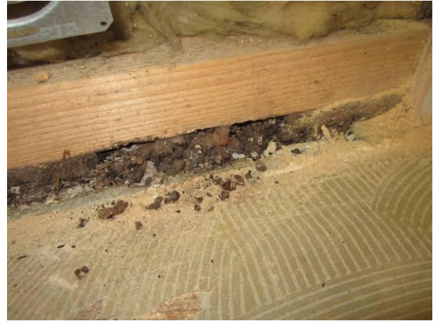
Kuva 10 RA1-avaus, alasidepuu lattiatasossa, alla juuttitilke/ MAT3 -näyte
