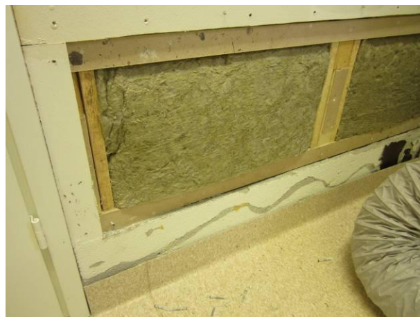
Kuva 17 Väliseinien alla ks-harkot.
