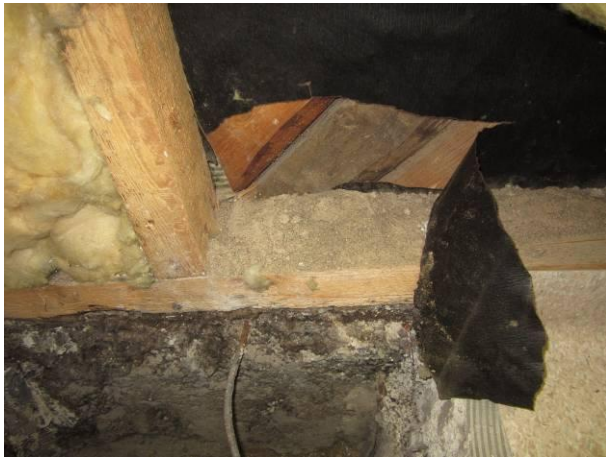
Kuva 15 RA2 alasidepuun päällä hiekkaa
