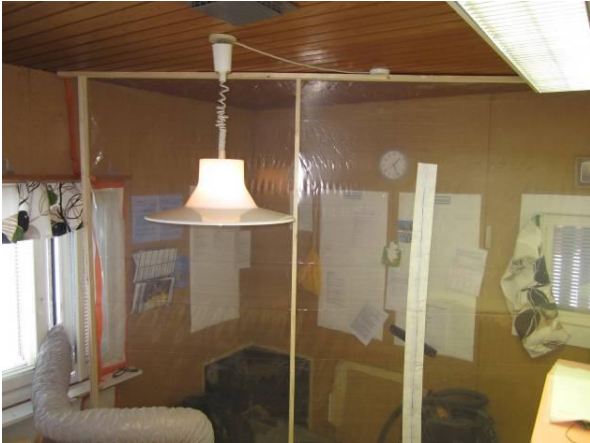
Kuva 31 Osastointi rakenneavaus RA3 varten
