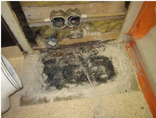
Kuva 11 Rakenneavaus RA1, kevytsorabetonin päällä pintalaatan alla on pikisively.
