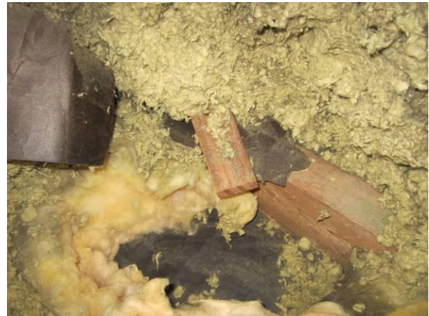
Kuva 6 Eristeenä puhallusvillaa ja levyvillaa, josta otettiin näyte MAT1
