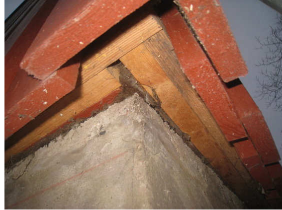
Kuva 8 Ulkoseinää on todennäköisesti lisälämmöneristetty.
