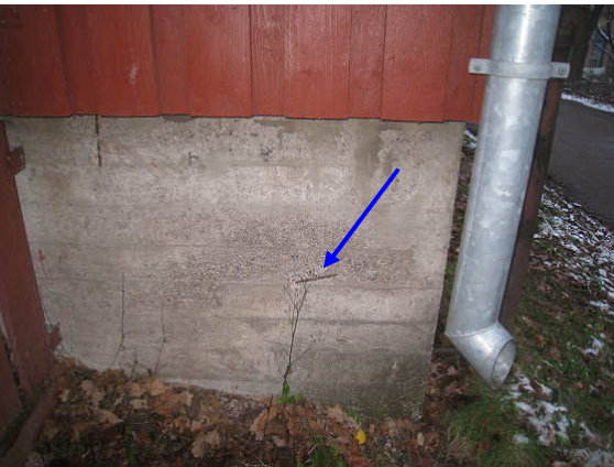
Kuva 5 Ruostunutta raudoitusta.
