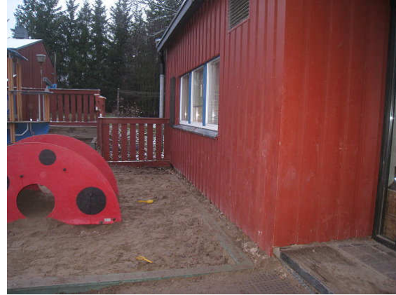
Kuva 2 Hiekkalaatikko on lähellä rakennusta.
