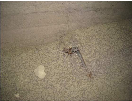
Kuva 3 Kosteus- ja mikrobivaurioitunutta sidepuuta.
