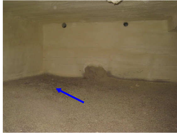
Kuva 2 Kulmissa täyttö tummempaa keskiosiin nähden.
