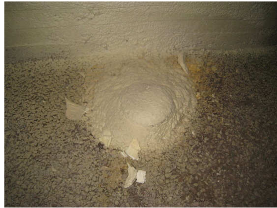
Kuva 4 Lähellä sisäänkäyntiä polyuretaanivaahdolla eristetty kansi tv.. Ympäriällä "kasvustoa".
