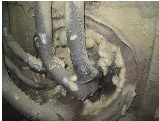
Kuva 5 Putkikanaalin lähtö tiivistetty polyuretaanilla.
