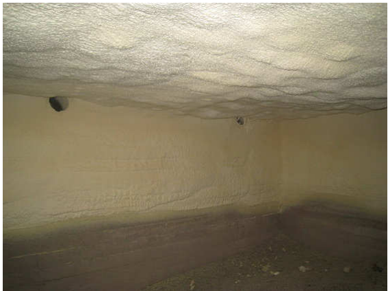
Kuva 6 Katto- ja seinäpinnat on eristetty polyuretaanivaahdolla.
