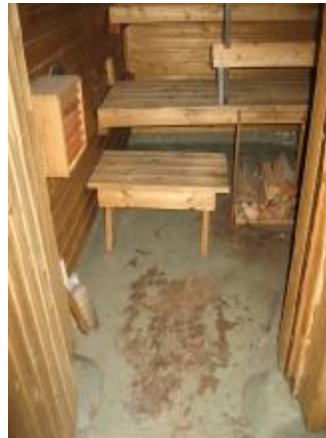
Löylyhuoneen puupinnat olivat tyydyttävässä kunnossa.
