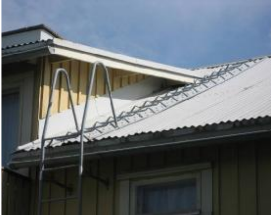
Harjakatto, jonka katteena toimii profiloitu vaaleanharmaa peltikate.
