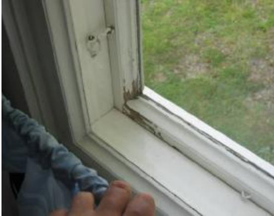
Ikkunat ovat kaksinkertaisia puuikkunoita.
