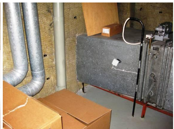
Kuva 8a ja b. Liikuntasalin tuloilmakammio sijaitsee kirjastonpääsisäänkäynnin portaiden alapuolella. Kammioista on säleikkö tekniseen tilaan ja ilmanotto liikuntasalin IV-koneelle. Katso kuvat 36a ja b, kohdasta 9 Ilmanvaihto.
