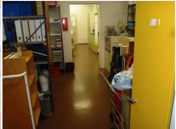
Kuva 6a ja b. Kirjaston eteläpäädyssä on maavarainen alapohjalaatta. Kirjaston lainausalin lattiapinnoite on uusittu noin 5 vuotta sitten. Kirjasvarastossa on alkuperäinen vinyylilaatoitus.
