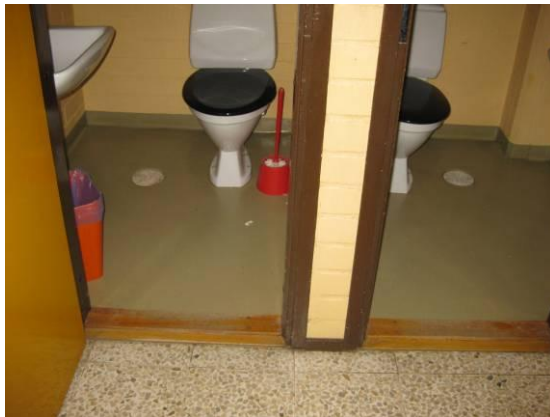
Kuva 10a, b, c ja d. Märkätilojen lattiapinnoitteena on keraaminen laatoitus tai kostean tilan muovimatto. Muutoin lattiapinnoitteena on linoleumimattoa, muovimattoa, vinyylilaatoitusta tai mosaiikkibetonilaattaa.
