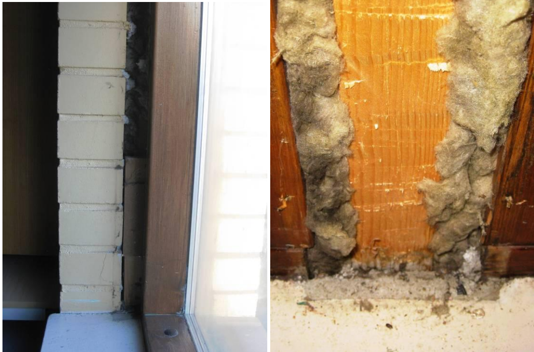
Kuva 26a ja b. Toisen kerroksen opetustilaan 201 tehdystä ikkunan reunan ja ikkunavälin rakenneavauksesta (RAK9) havaittiin ikkunan tukeutuvan ulkoseinärakenteen ulkokuoren tiilen päälle. Ulkoseinän sisäkuoren ja ikkunakarmien välillä on lähes eristepaksuuden kokoinen väli. Mineraalivilla on tummunut ilmavuodoista. Mineraalivillaeristeestä otettiin materiaalinäyte sekä ikkunan reunasta (5317-) että ikkunavälistä (5317-2).
