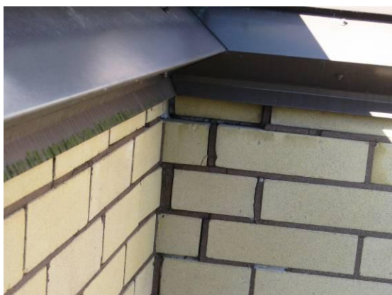
Kuva 34a ja b. Räystäsrakenne on lyhyt ja reunapellitys on irti alustastaan yksittäisissä kohdissa. Myrskypeltiä ei ollut havaittavissa joka paikassa. Pellityksen alla oleva bitumikermi on paikoin jäänyt lyhyeksi ja vedellä on mahdollisuus kulkeutua seinärakenteeseen räystäsrakenteessa olevan raon kautta.
