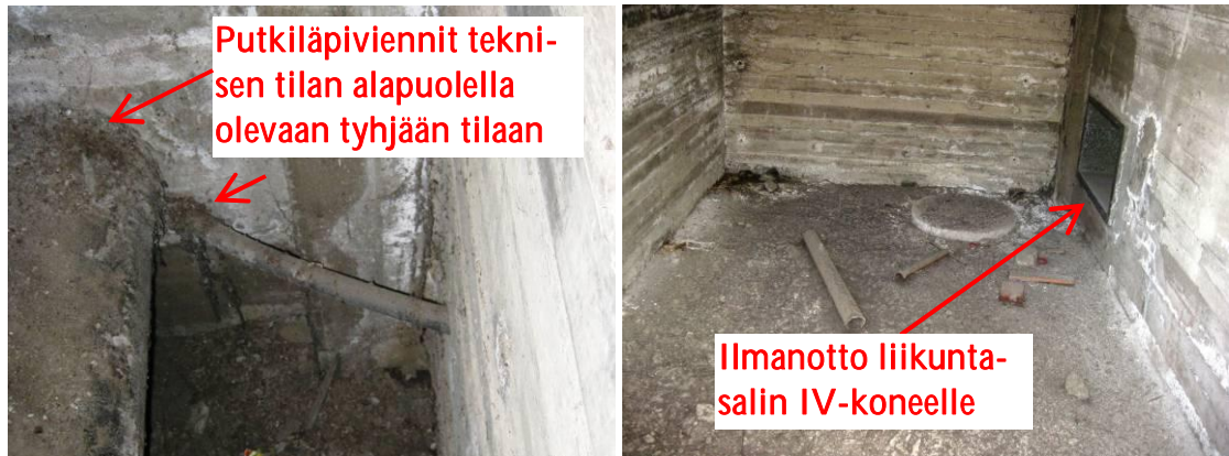
Kuva 36a ja b. Liikuntasalin IV-koneen tuloilmakammioista on putkiläpiviennit teknisen tilan alapuolella olevaan tyhjäan tilaan sekä ilmanotto IV-koneelle.
