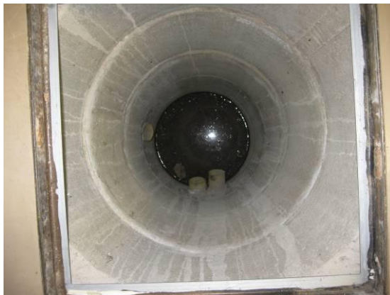
Kuva 11a ja b. Urheiluvälinevarastossa oleva salaojakaivo aukaistiin. Kaivon vedenpinnan taso oli salaojaputkien alapuolella. Käytävän 115 eteläpäässä on pieni syvennys väestönsuojatilan edessä. Syvennykseen on asennettu polystyreenilevytyks ja sen päälle karkea matto, jonka jälkeen käytävän lattiapinta on saatu lähestulkoon samaan tasoon.
