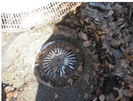
Kuva 33a ja b. Sadevesikaivojen ympärillä oli monin paikoin runsaasti lehtiä. Osa lehdistä on päässyt roskasihdin läpi. Lehdet voivat tukkia sadevesien poistoputket.
