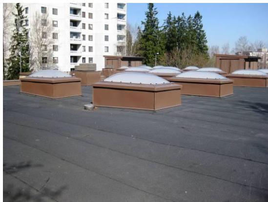
Kuva 32a ja b. Vesikatolle kulku tapahtuu ulkokautta rakennuksen eteläpäädyn huoltopihalla olevia avattavia seinätikkaita pitkin. Vesikatolla on toistakymmentä muovikupuikkunaa.
