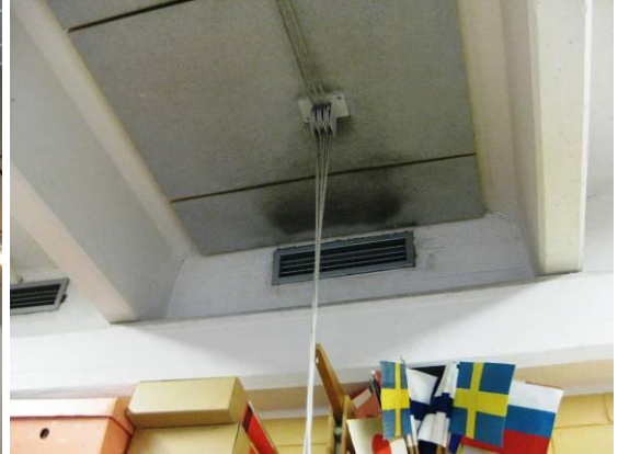
Kuva 38a ja b. Tilojen kattopintana on pääsääntöisesti maalattu betonirakenne, joka on pinnoitettu reunoiltaan avonaisilla akustointilevyillä. Akustointilevyissä on monin paikoin tummaa pölykertymää.
