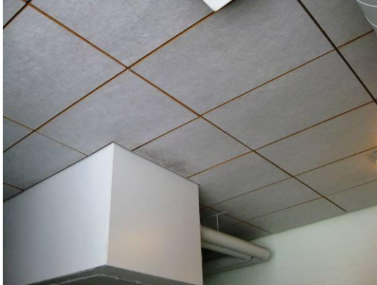
Kuva 38a ja b. Tilojen kattopintana on pääsääntöisesti maalattu betonirakenne, joka on pinnoitettu reunoiltaan avonaisilla akustointilevyillä. Akustointilevyissä on monin paikoin tummaa pölykertymää.
