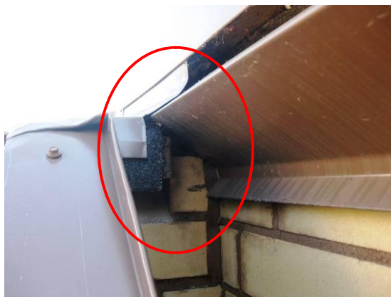
Kuva 34a ja b. Räystäsrakenne on lyhyt ja reunapellitys on irti alustastaan yksittäisissä kohdissa. Myrskypeltiä ei ollut havaittavissa joka paikassa. Pellityksen alla oleva bitumikermi on paikoin jäänyt lyhyeksi ja vedellä on mahdollisuus kulkeutua seinärakenteeseen räystäsrakenteessa olevan raon kautta.
