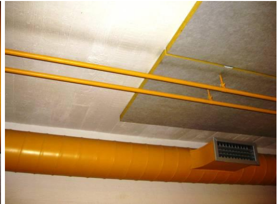
Kuva 39a ja b. Useiden tuloilmakanavien tuloilmasäleiköt olivat pölyisiä. Ohjautuu monin paikoin reunoiltaan avonaisien akustointilevyjen pintaa ja voi näin ollen lisätä kuitujen irtomaista levyjen reunoista.
