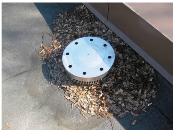
Kuva 33a ja b. Sadevesikaivojen ympärillä oli monin paikoin runsaasti lehtiä. Osa lehdistä on päässyt roskasihdin läpi. Lehdet voivat tukkia sadevesien poistoputket.
