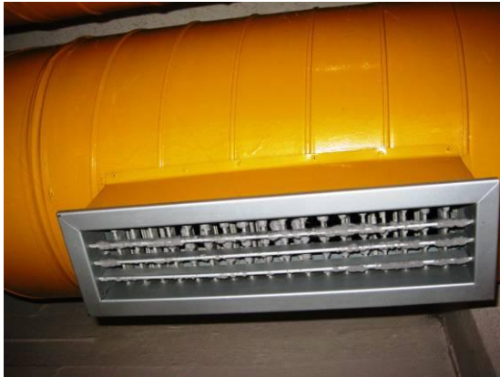
Kuva 39a ja b. Useiden tuloilmakanavien tuloilmasäleiköt olivat pölyisiä. Ohjautuu monin paikoin reunoiltaan avonaisien akustointilevyjen pintaa ja voi näin ollen lisätä kuitujen irtomaista levyjen reunoista.
