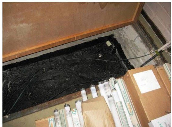
Kuva 7a ja b. Liikuntasalissa, voimisteluvälinevarastossa ja liikuntatilan eteisessä on lattiapinnoitteena joustolattia. Edellä mainitut tilat ovat muita ensimmäisen kerroksen tiloja noin 1,4 m alempana Näyttämövaunu on varastoitu teknisen tilan ja oppilastyövaraston lattian alapuoliseen tilaan. Sähköpääkeskuksessa lattian syvennyksessä on musta, bitumimainen massa.
