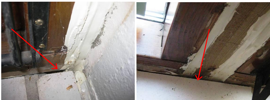
Kuva 23a ja b. Ensimmäisen kerroksen opetustilan 117 ikkunaliittymiä on tiivistetty elastisella massalla tilan muiden korjaustöiden yhteydessä. Tilaan tehdystä ikkunan rakenneavauksesta (RAK8) havaittiin selkeitä rakoja ulkoseinän sisäkuoren ja ikkunakarmien välillä.
