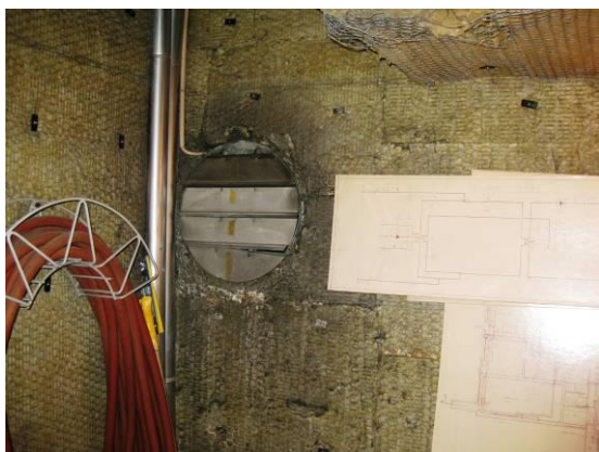
Kuva 8a ja b. Liikuntasalin tuloilmakammio sijaitsee kirjastonpääsisäänkäynnin portaiden alapuolella. Kammioista on säleikkö tekniseen tilaan ja ilmanotto liikuntasalin IV-koneelle. Katso kuvat 36a ja b, kohdasta 9 Ilmanvaihto.
