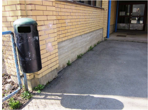
Kuva 2 Sokkeliä vasten ei ole ns. reunamakkaraa.
