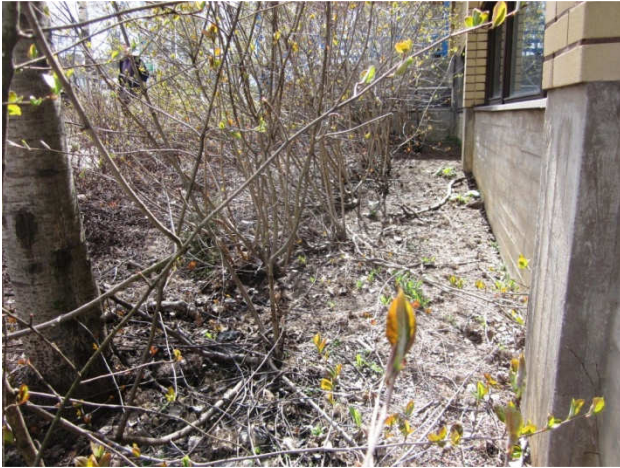
Kuva 13 Alaosalla pensasistutusalue. Sokkelia vasten multamaata.
