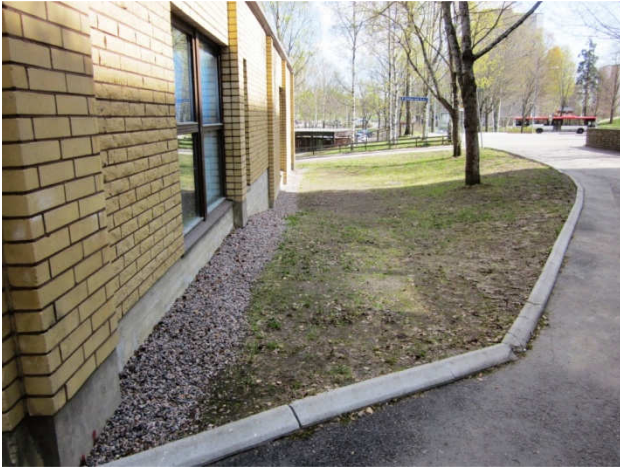
Kuva 9 Eteläpäätyä. Sokkelin vierellä sepelikaistale.
