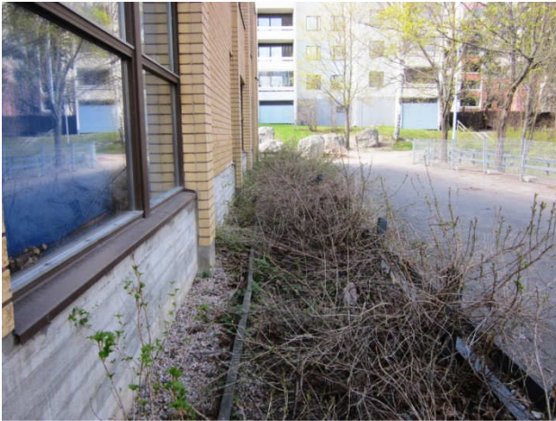
Kuva 3 Pohjoisen puoleista päätyä.
