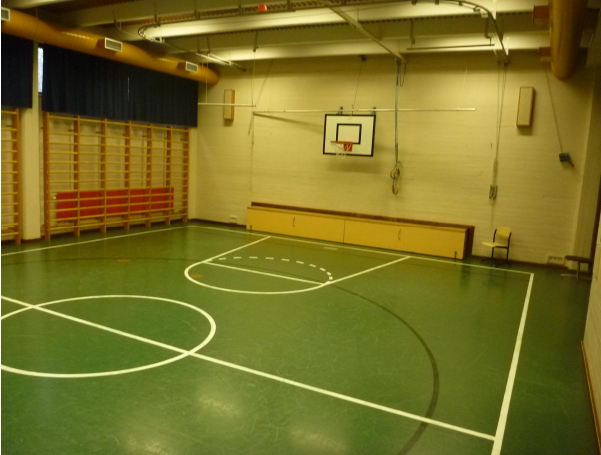
Kuva R16. Liikuntasalista mitattiin kosteuksia ulkoseinän läheltä ja muualtakin lattiasta porareikämittauksella.
