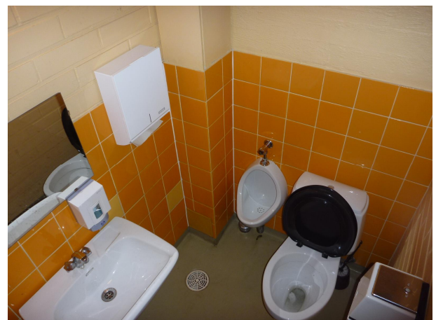
Kuva R25. Sisätilat suositellaan remontoitavaksi 5-10 vuoden kuluessa.
