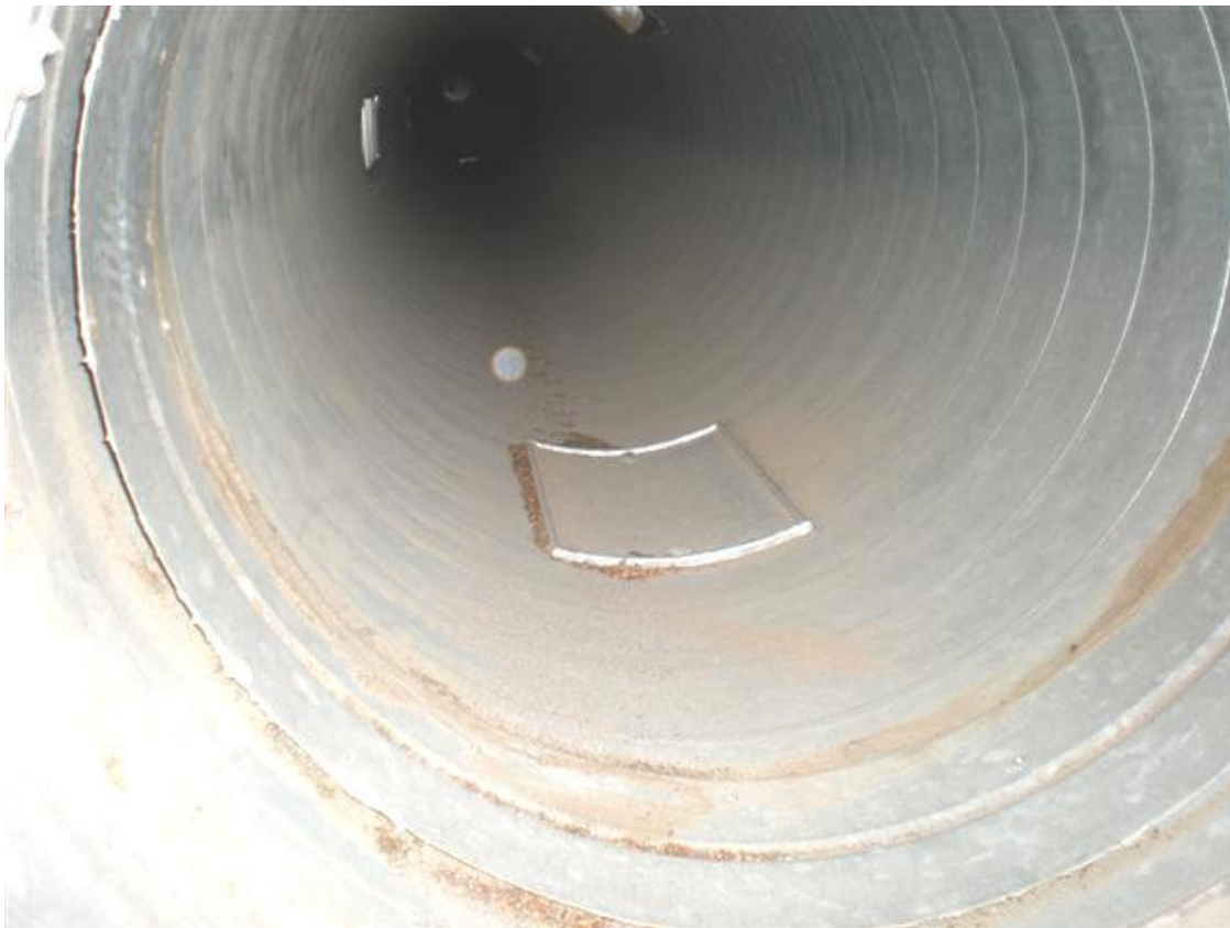
Kuva 3. Tulokanavissa on paikka paikoin ulkoa tullutta likaa ja roskaa.
