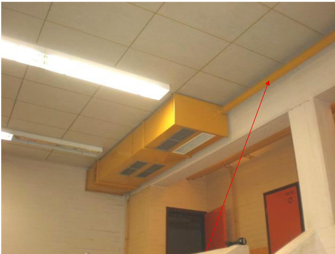
Kuva 8. Alapohjan tuuletusta varten on vedetty kanava liikuntasalin poistokanavasta.
