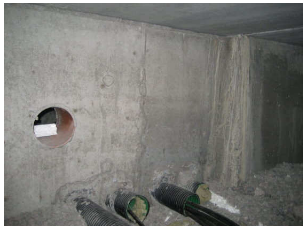
Kuva 12 Alustatilalohkojen välinen tuuletusreitti on tässä hyvin auki
