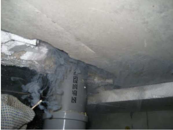
Kuva 25 Viemärläpiviennin tiiveyskokeita tehtiin muutamia merkisavutikuin.
