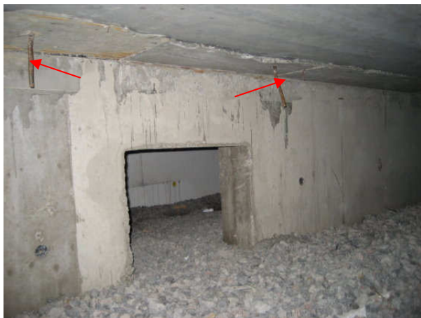
Kuva 11 Sepelikerroksen madaltama 600x600 -kulkuaukko audit.salin 120 sivuonteloon. Katossa on harjateräspätkät.
