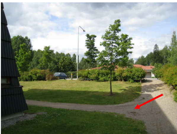
Kuva 29 Koilliskulmalla paikoitusalueelta valuvat pintavedet eivät valu sv-kaivoon.
