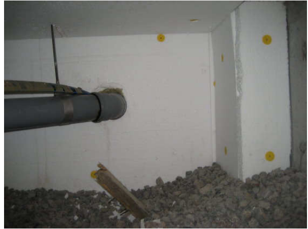
Kuva 8 Viemäri ja kaapeli on viety sokkelin/perusmuurin läpi tuuletusputkelle varustusta aukosta. Lankunpää sepelissä.
