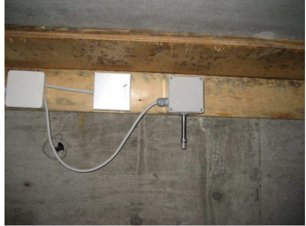
Kuva 26 Alustatilassa olevia muottilaudoituksia ja mittausantureita tilan RH128 alla.
