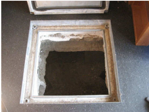
Kuva 1 Kulkuluukku on tiivis ja on pultattu kiinni 6-kolopultein.
