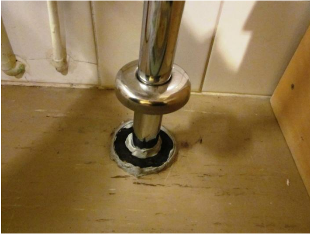
Kuva 27 Poistoputkea on tiivistetty massalla.
