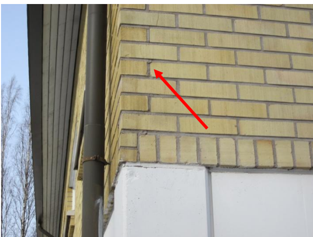
Kuva 16 Tiilimuurauksessa halkeama.
