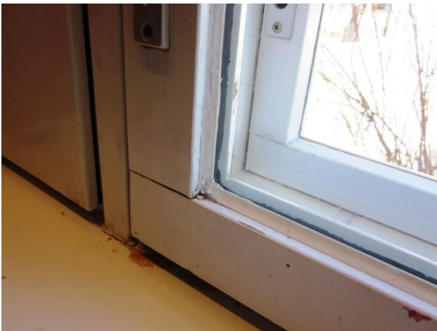
Kuva 20 Lasin ja puitteen väli tiivistetty silikonilla.
