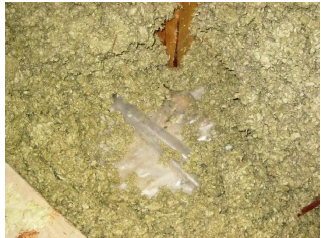
Kuva 5 Höyrynsulkumuovin limitys.
