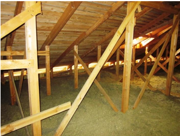
Kuva 4 Ullakottila tuulettuu hyvin.
