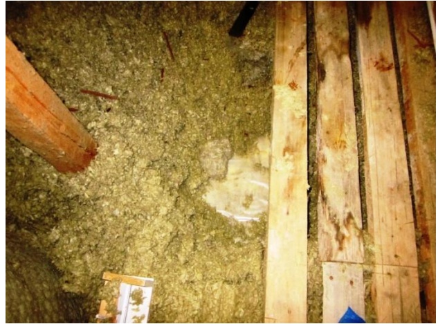
Kuva 9 Kävelysillassa vesijälkiä.
