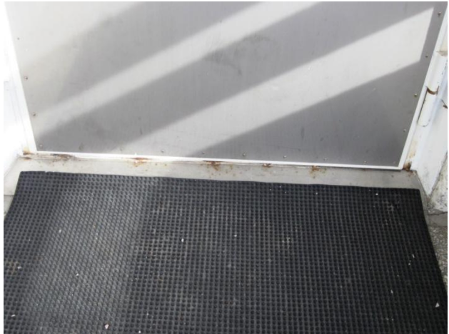
Kuva 23 Teräslasioven alakarmissa ruostetta.
