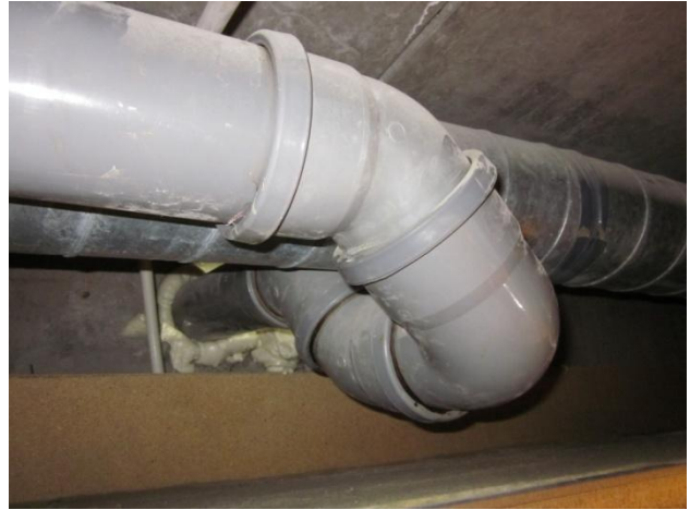
Kuva 28 Viemäriputki viety IV-kanavan alakautta.
