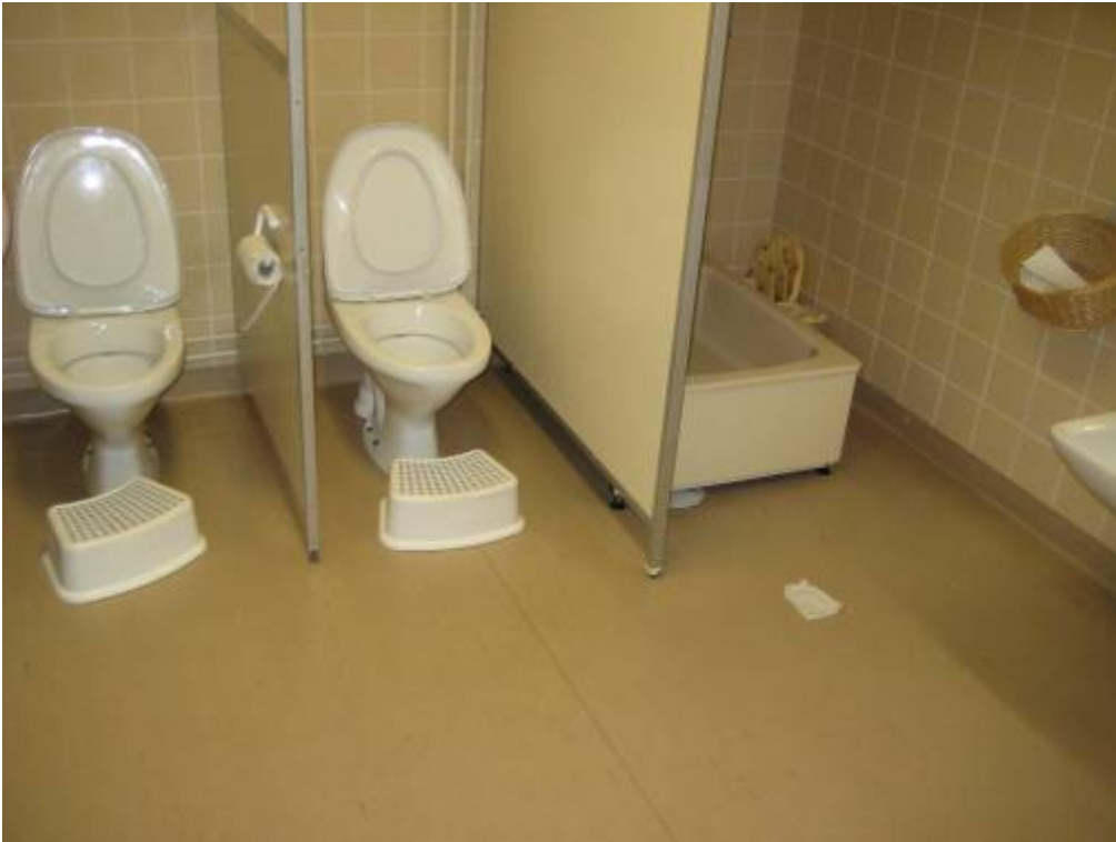
RAK-KUVA 13: Märkätilojen rakenteiden kunto arvioitiin tyydyttäväksi niiden ikääntymisestä huolimatta.
