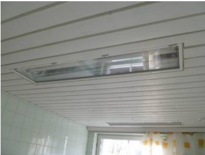
S-KUVA 8. Vesileikkihuoneen valaistus
