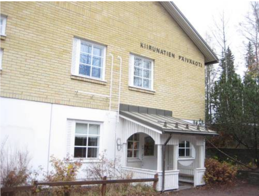
RAK-KUVA 6: Rakennuksesta hätäpoistuminen toteutettu ikkunasta portaita pitkin. Käytännössä viereisen tilan poistumisreitti on turvallisempi pienemmän putouskorkeuden takia (alapuolella sisääntulokatosis).
