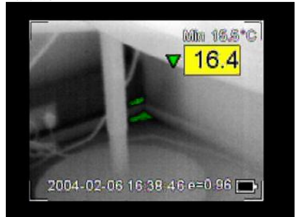
Huone 210, ikkunaseinä, oikea alakulma, alavälipohjan liitos. Min 15.5/tr 22.0
