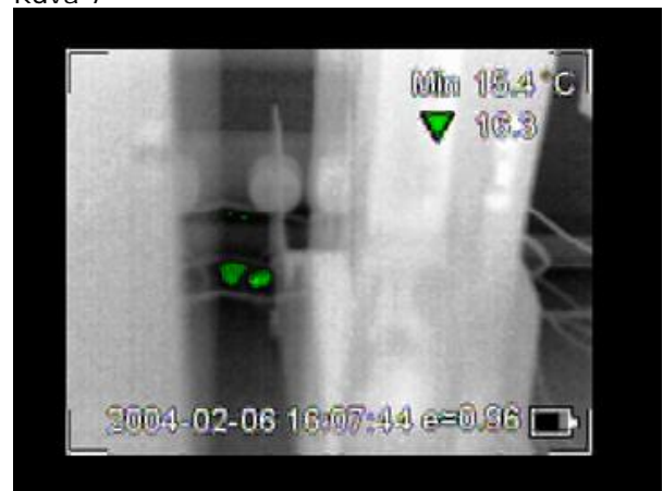
Huone 222, ikkunaseinä, keskiosa, alavälipohjan liitos. Min 15.4/tr 21.0
