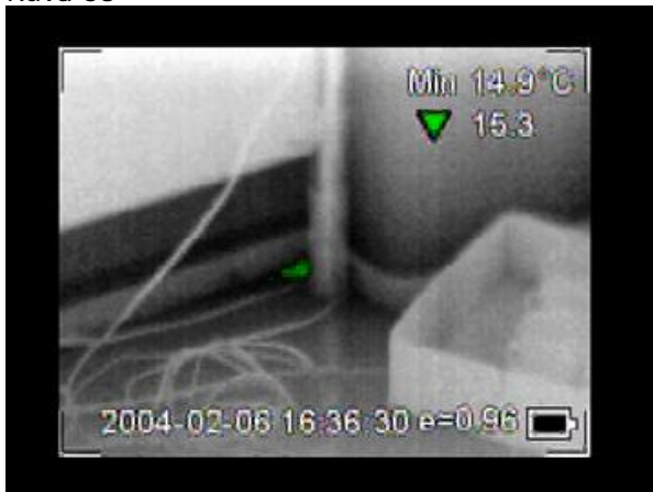
Huone 212, ikkunaseinä, ikkunasyvennöksen ovasemmalla puolella, alavälipohjan liitos. Min 14.9/tr 21.5
