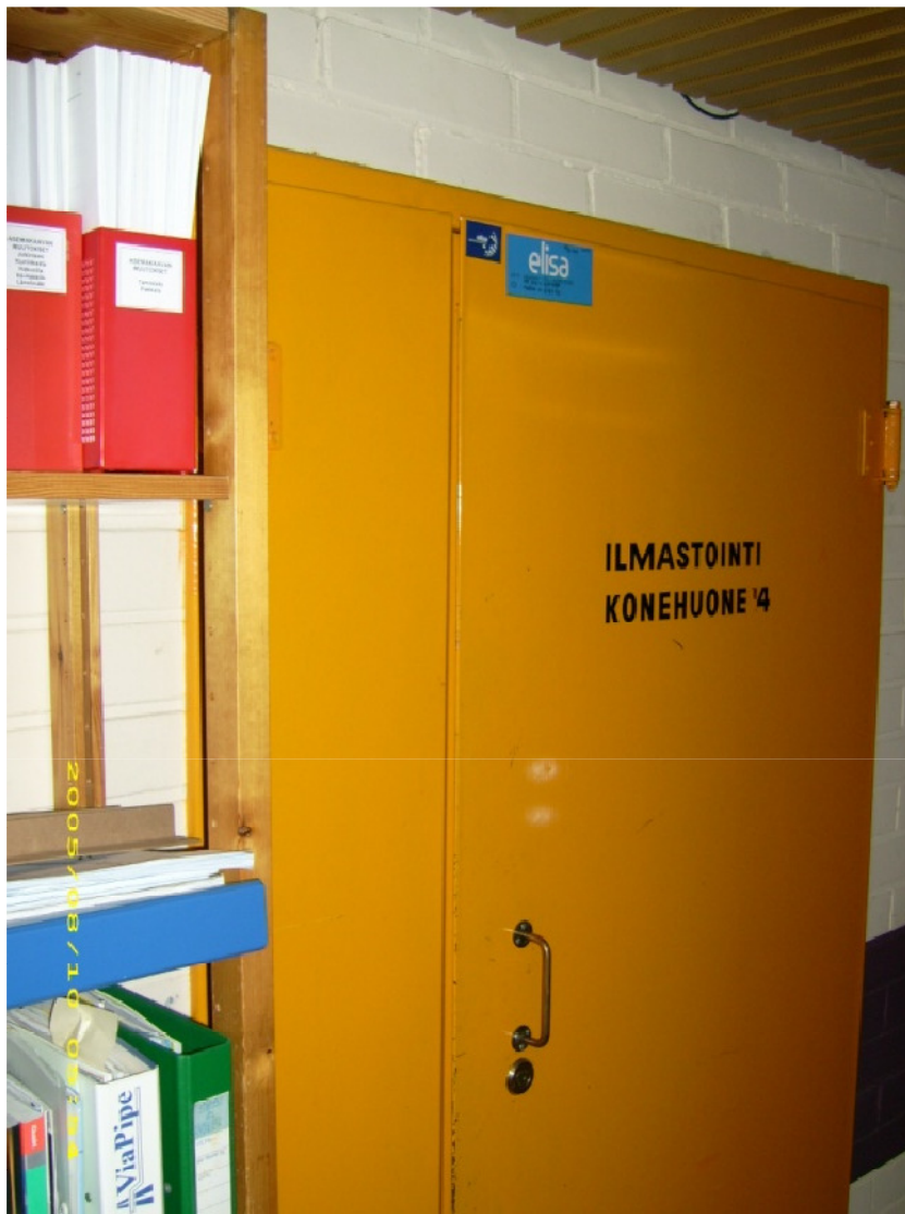
IV-konehuoneen ovi avautuu itäkäytävälle.
