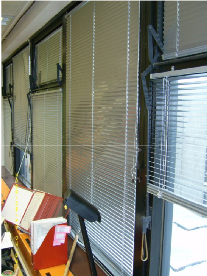
Sisäpuolisia sälekaihtimia länsisiivessä.
