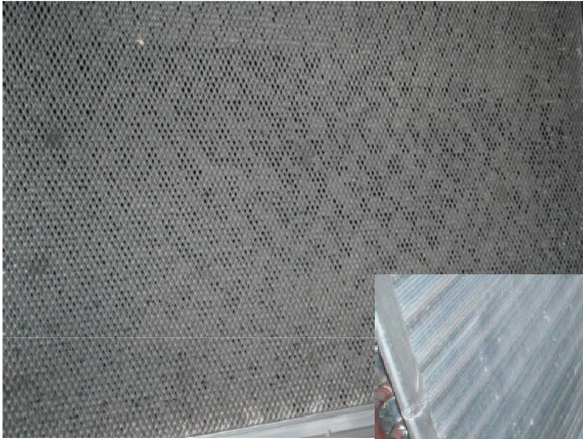
Likainen sähkösuodatin. Suodattimella kipinöintiä.
