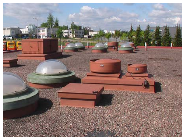
Kuva 6. Toimistosiiven vesikattoa läpivienteineen ruokalan/keittiön yläpuolella.
