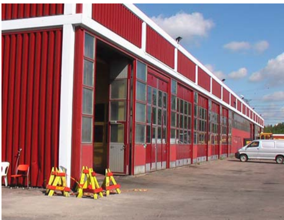
Kuva 15. Hallien isot ovet on uusittu n. 2v sitten.
