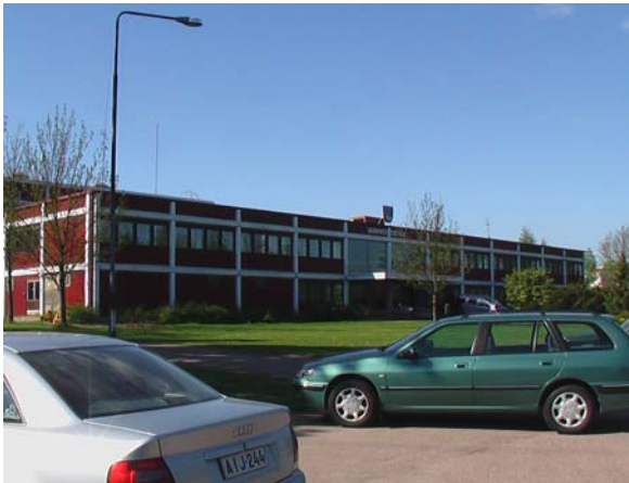
Kuva 2. Toimistosiipi, julkisivu pohjoiseen. Toimistosiivessä on 2 kerrosta. Vesivuoto Vantaan veden tiloihin (1.-krs.) sijaitsee kuvasta katsottuna oikeassa päädyssä.
