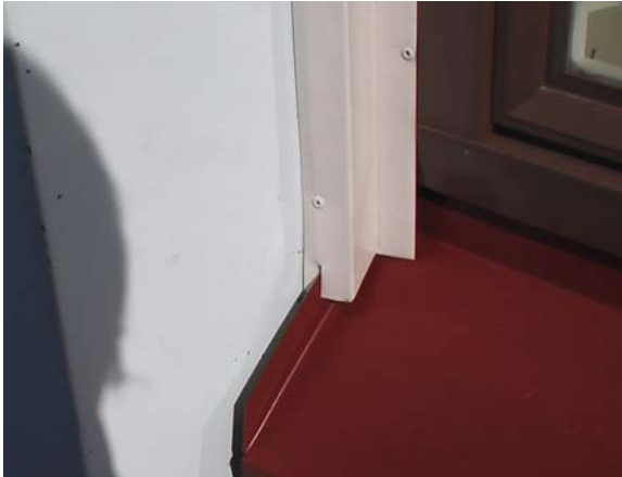
Kuva 13. Uusittuja ikkunoita (Al -ulkopuite) ja ikkunapellityksiä toimistosiivessä eteläpuolella.
