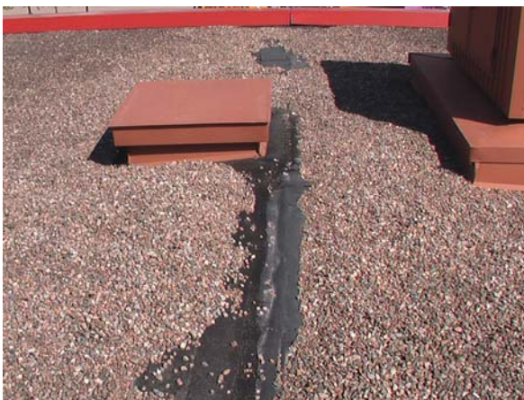
Kuva 21. Liikuntasauva toimistosiiiven keskellä on hieman epäilyttävä.
