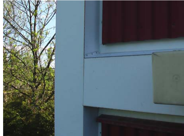
Kuva 10. Rankapeltien liittymä nurkassa. Huomaa vaakapellin ylöstaitto pystypeltiä vasten (vaatisi kittauksen).
