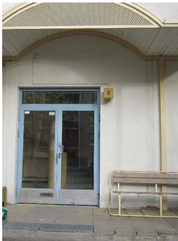
Kuva S-8. Sisäänkäynnin numerovalaisin.
