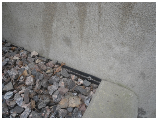
Kuva R-6. Sokkeleissa on patolevyt sekä vierusrastukset.
