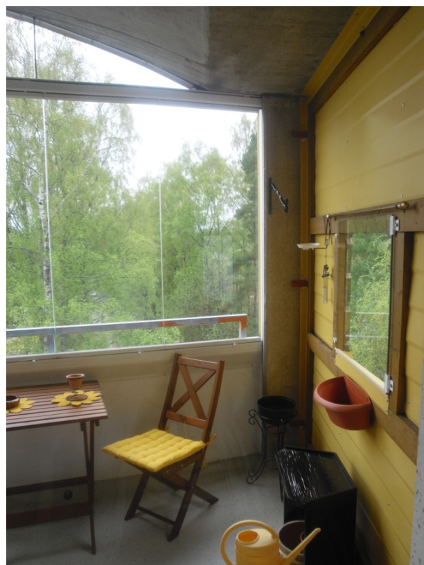
Kuva R-10. Parvekekaiteet ovat teräsbetonia ja uloimmat pielet ovat puurakenteisia.
