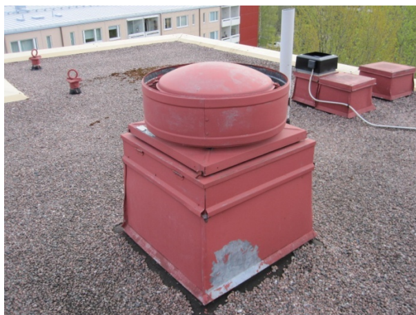
Kuva LVI-14. Huippuimuri mallia STDE (Fläkt Oy).
