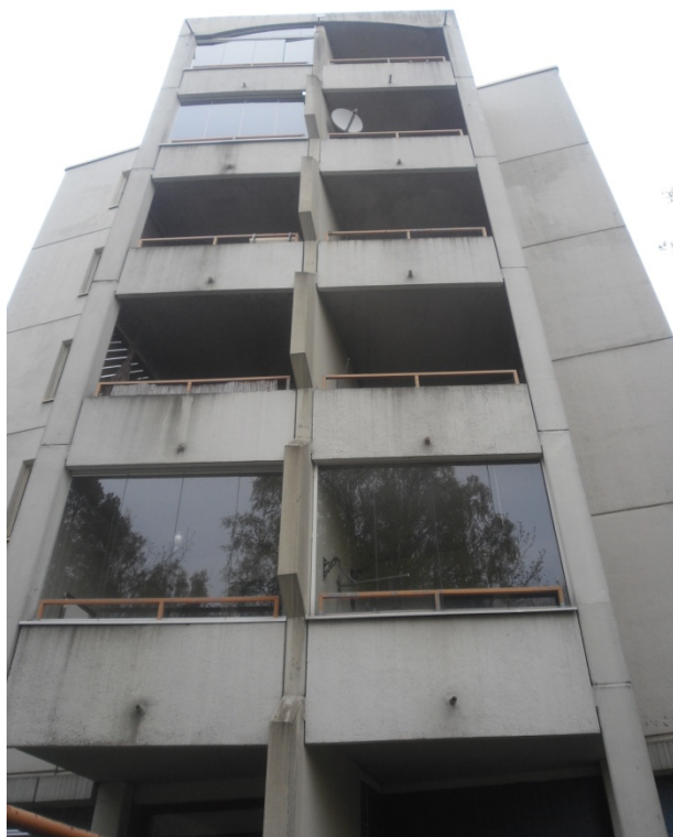
Kuva R-9. Yleiskuva parvekkeista.
