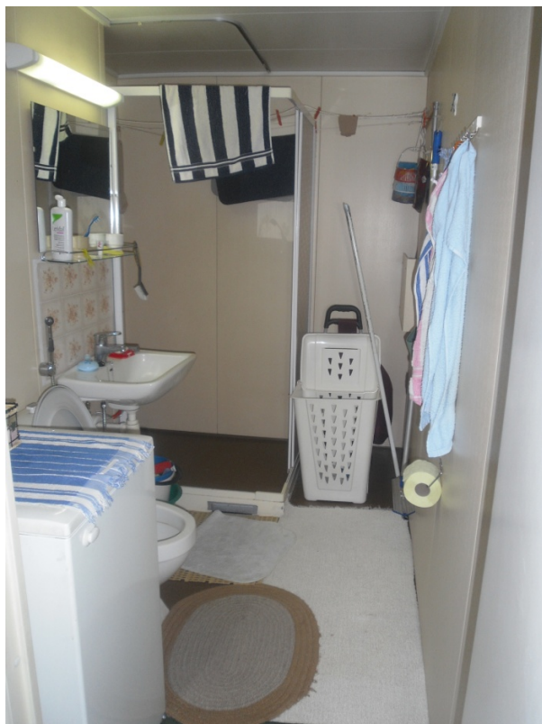
Kuva R-19. Kylpyhuoneet ovat ns. tilaelementtejä.
