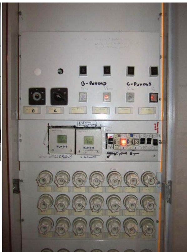
Kuva S-4. Ullakon kiinteistökeskus.
