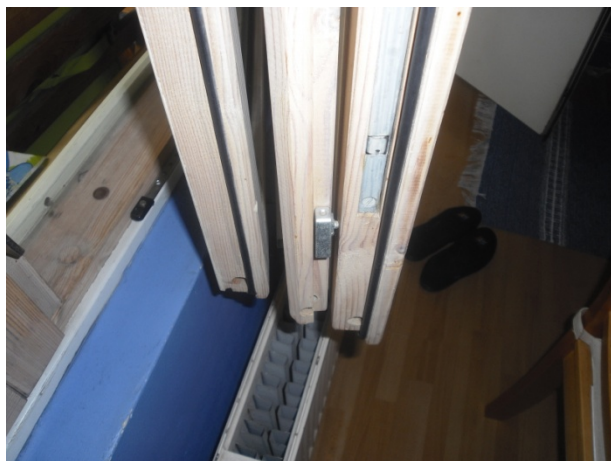
Kuva R-13. Ikkunat ovat puurakenteisia sisään aukeavia MSK-ikkunoita.
