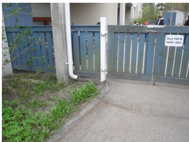
Kuva R-5. Parvekekattojen vedet johdetaan syöksytorvilla maastoon.
