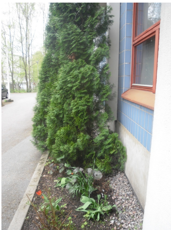
Kuva R-1. Kuvassa kasvillisuus on liian lähellä rakennusta ja niiden poistamista tulisi harkita.
