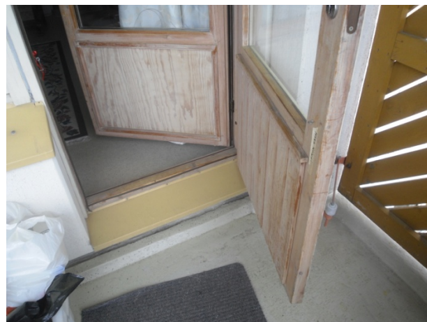
Kuva R-14. Parvekeovet ovat puurakenteisia sisään – ulos aukeavia ikkunaovia.
