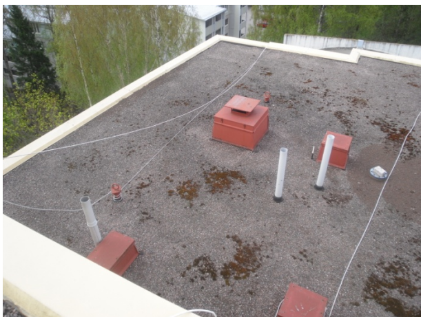
Kuva R-15. Vesikatto on tyypiltään ns. tasakatto.
