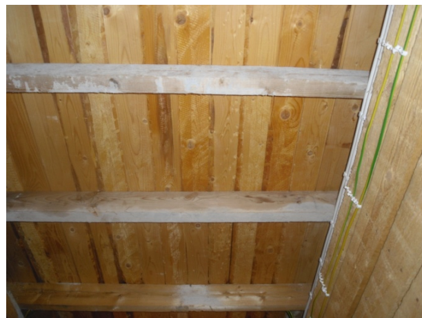
Kuva R-16. Ullakon kohdalla vesikatto on puurakenteinen.
