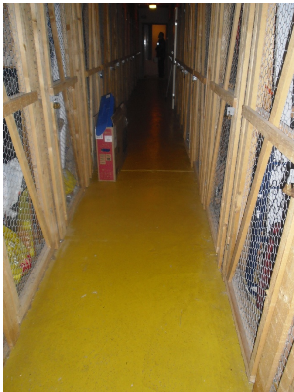
Kuva R-22. Kellaritilat ovat pääosin alkuperäisessä kunnossa.
