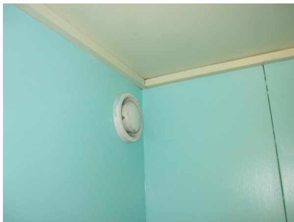
Kuva LVI-16. Kylpyhuoneen poistoilmaventtiili.
