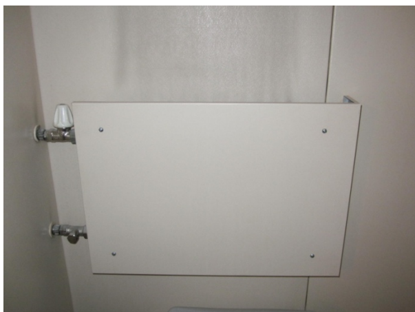
Kuva LVI-9. Käyttövesipatteri kylpyhuoneessa.
