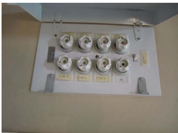
Kuva S-9. Huoneistoryhmäkeskus (yksivaiheinen).
